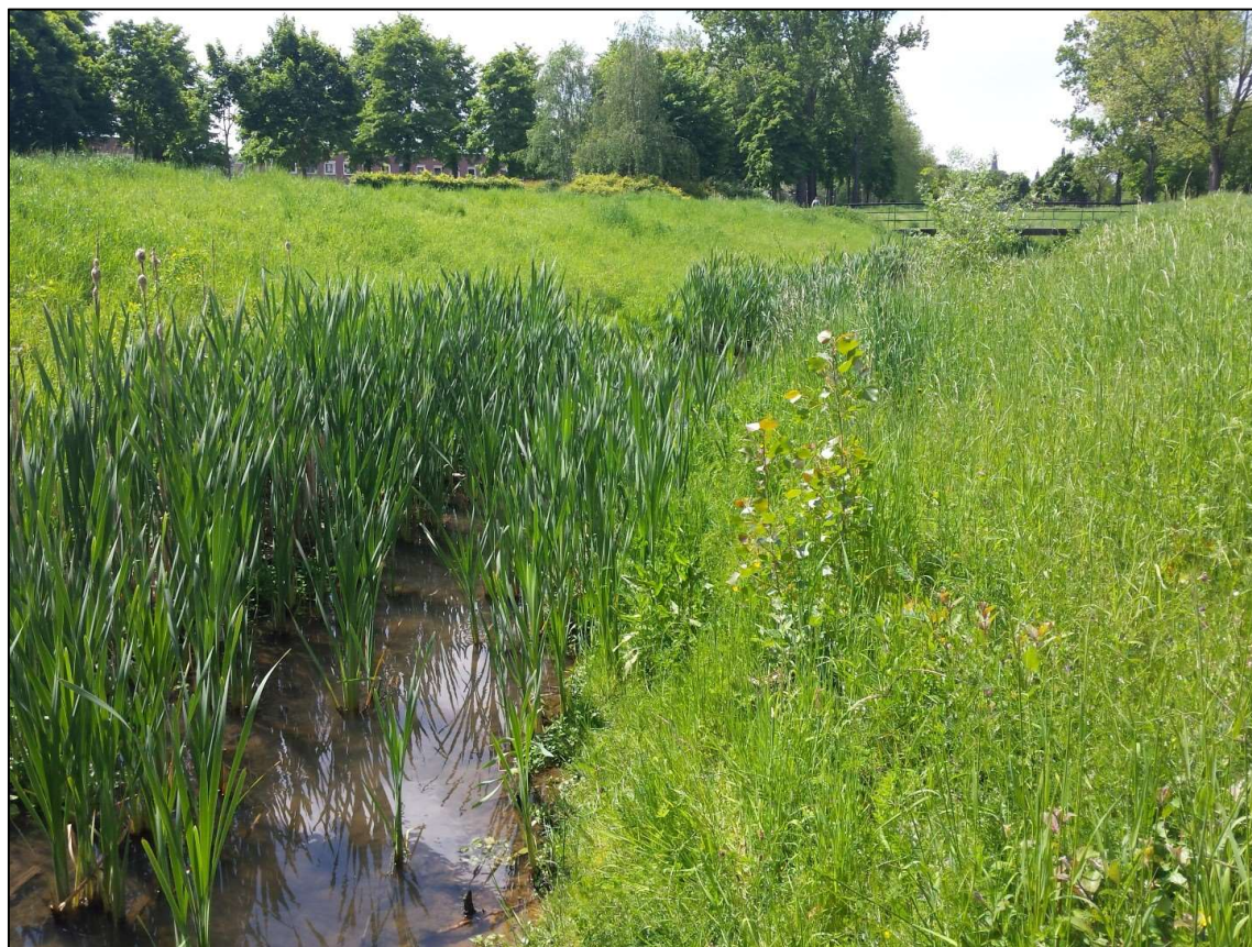
Figuur 6: Zicht op de Caumerbeek met iets verder de fietsbrug die vervangen wordt.
