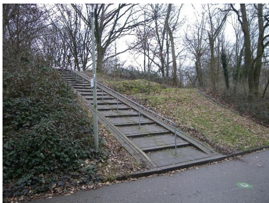
Figuur 10: Aansluiting Bruinkoolweg-mijnspoor. Dit betreft het oostelijk landhoofd voor de brug.
