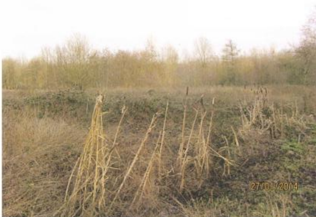
Perceel U 1364 niet inspecteerbaar i.v.m. begroeiing.
