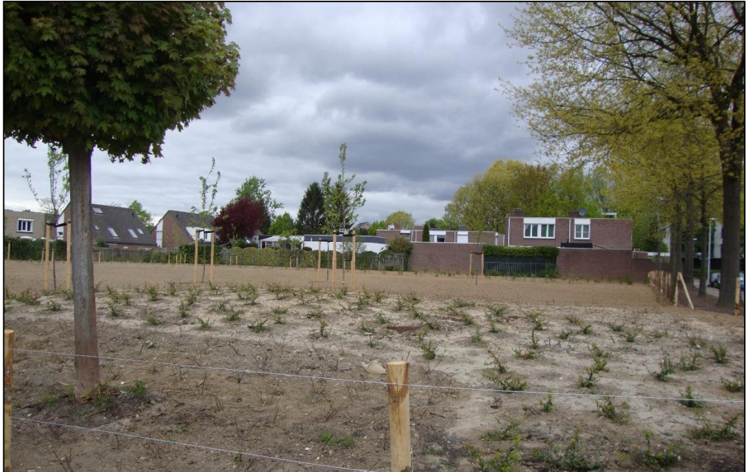
De projectlocatie, waar de werkzaamheden voor de aanleg van het parkje reeds in gang zijn gezet (1)
