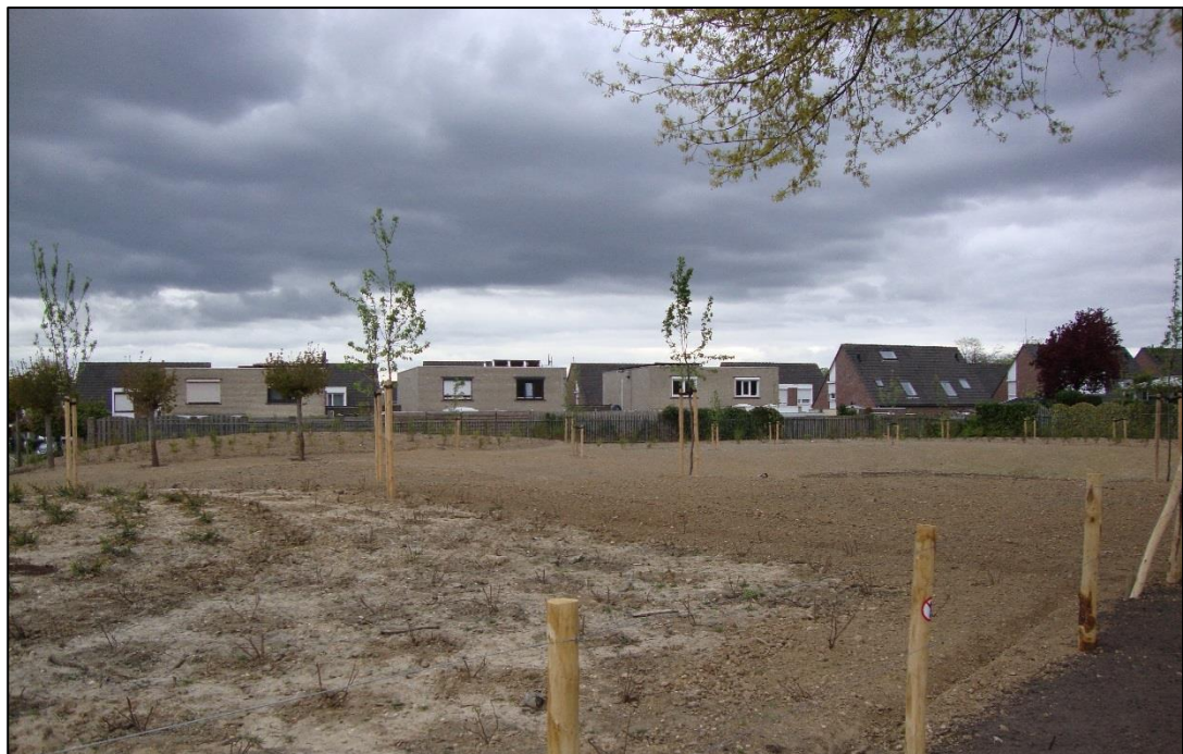
De projectlocatie, waar de werkzaamheden voor de aanleg van het parkje reeds in gang zijn gezet (2)
