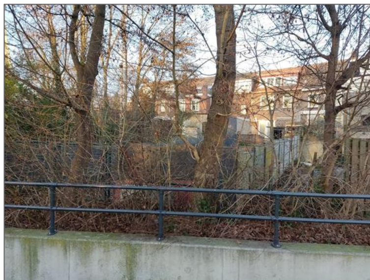
Figuur 2.4 Achteraanzicht van de te slopen woningen
