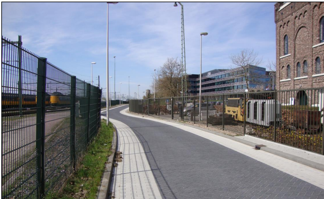
Ten westen van het Mijnmuseum (op de foto rechts), op een afstand van circa 85 meter, bevindt zich het nieuwe CBS-gebouw. Direct ten zuiden van de projectlocatie (op de foto links) bevindt zich het spoortraject Heerlen-Sittard.
