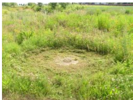
Figuur 11: In de berm aan de oostzijde ligt een reeks putten van de hemelwaterafvoer.
