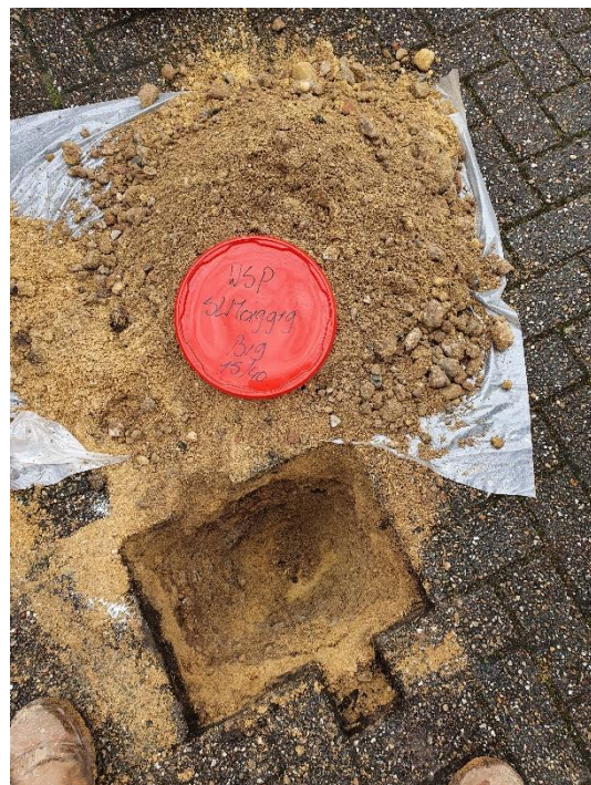
Foto proefgat B19
