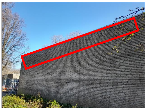
Figuur 5.3.1: Open stootvoegen aan achterzijde 'Jan Linders'
