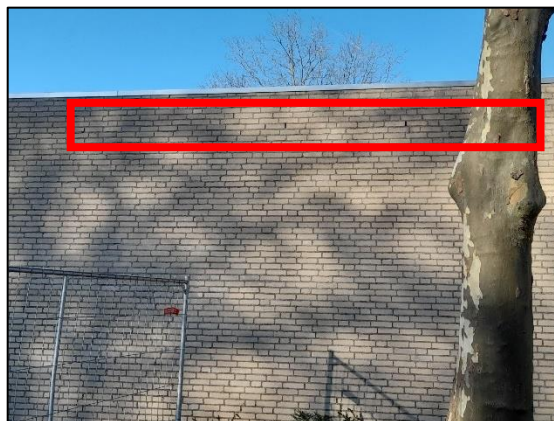
Figuur 5.3.2: Open stootvoegen aan achterzijde 'Shoeby' en leegstaand pand
