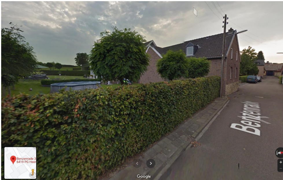
Foto's bestaande situatie
