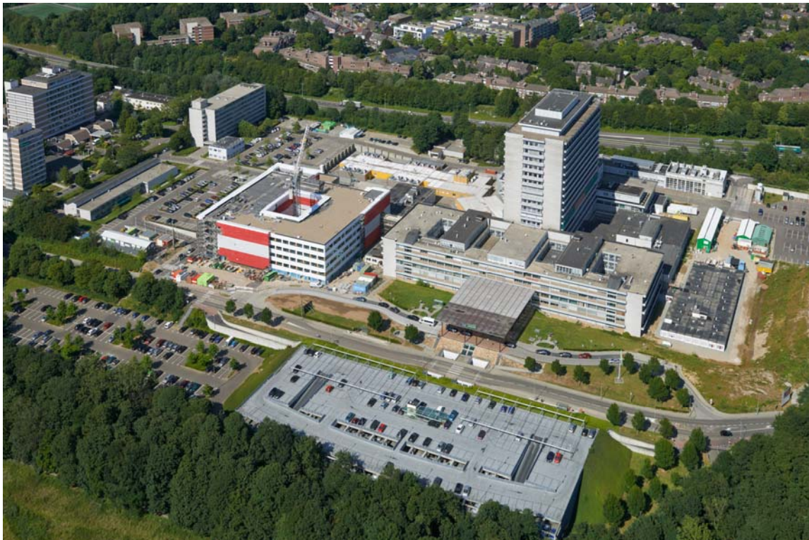
Afbeelding 10: Luchtfoto van het plangebied met gebouw Q in aanbouw
