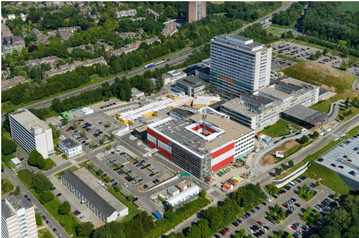
Afbeelding 12: Luchtfoto van het plangebied met gebouw Q in aanbouw
