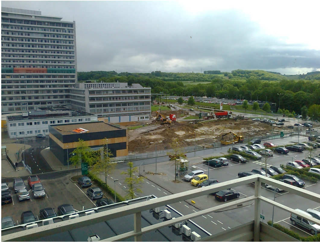
Afbeelding 7: Uitzicht op het westelijke bezoekersparkeerterrein vanuit de kantoorflat. De bouwwerkzaamheden voor gebouw Q zijn gestart. Foto: Kragten
