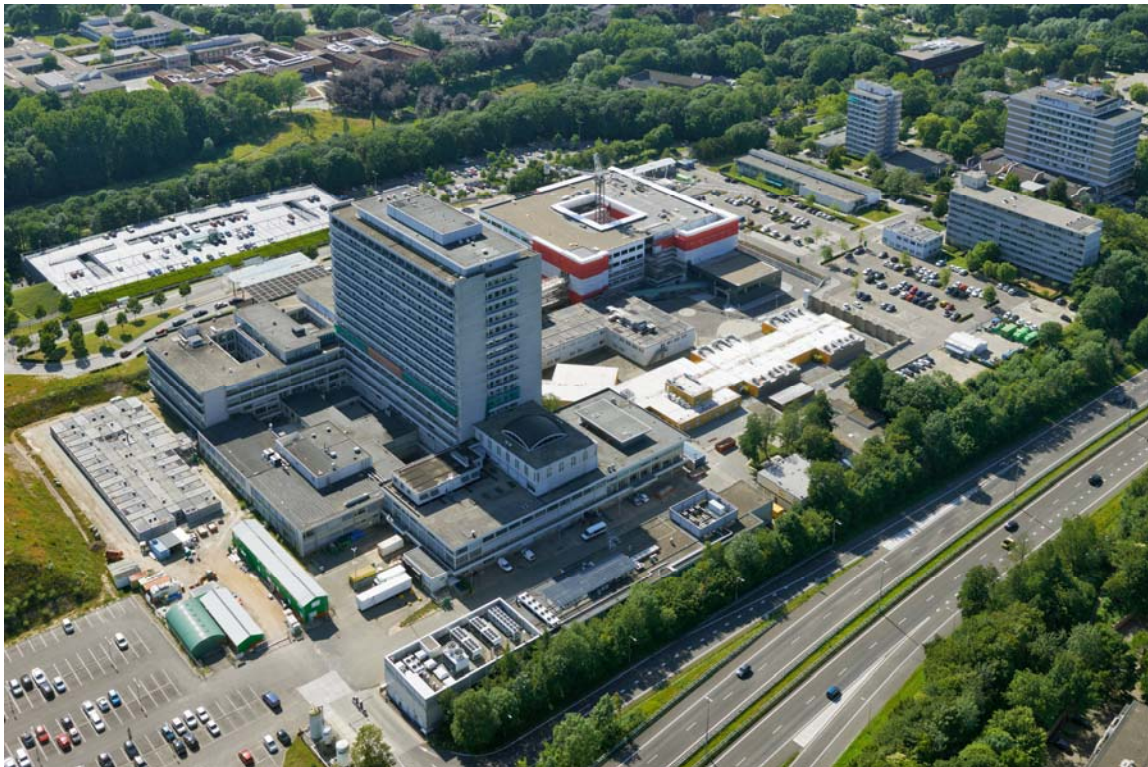
Afbeelding 11: Luchtfoto van het plangebied met gebouw Q in aanbouw
