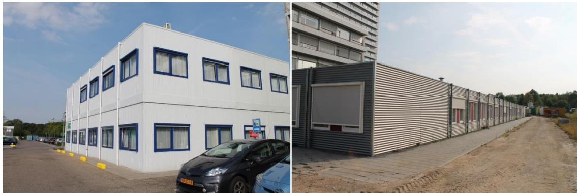
Afbeelding 5: De te slopen gebouwen X (links) en Y (rechts).
