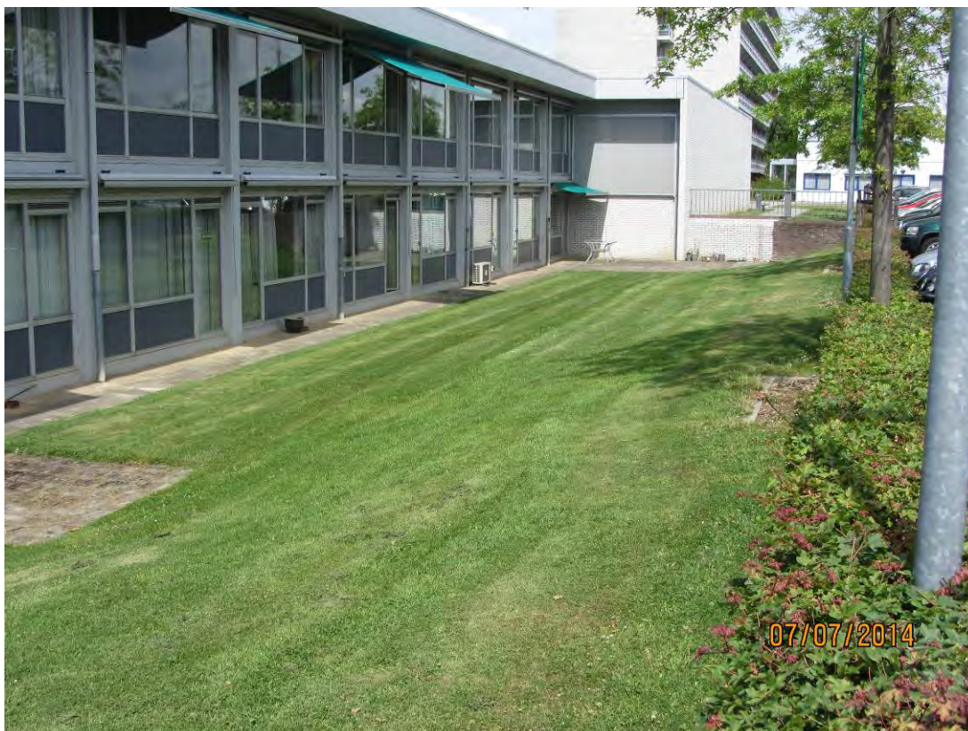
Rondom gebouwen noordzijde onderzoekslocatie.
