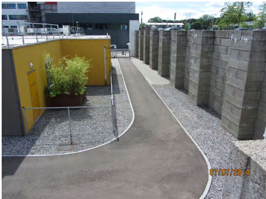
Achterzijde van ambulance/eerste hulp (gebouw P).
