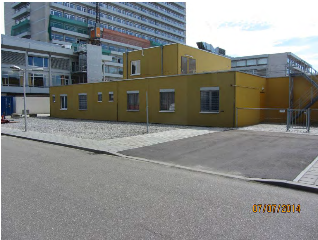
Achterzijde van ambulance/eerste hulp (gebouw P).
