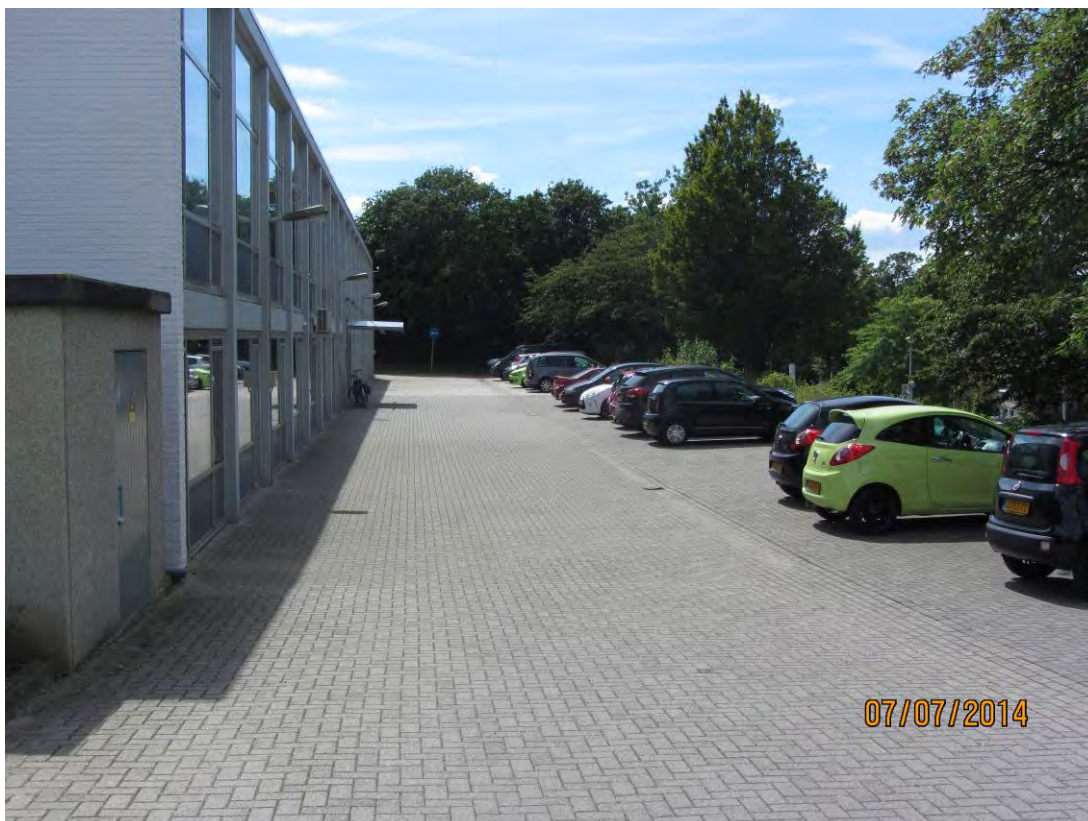
Achterzijde gebouwen noordzijde onderzoekslocatie.
