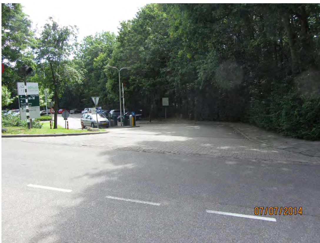
Ingang parkeerplaats (vanaf Henri Dunantstraat).
