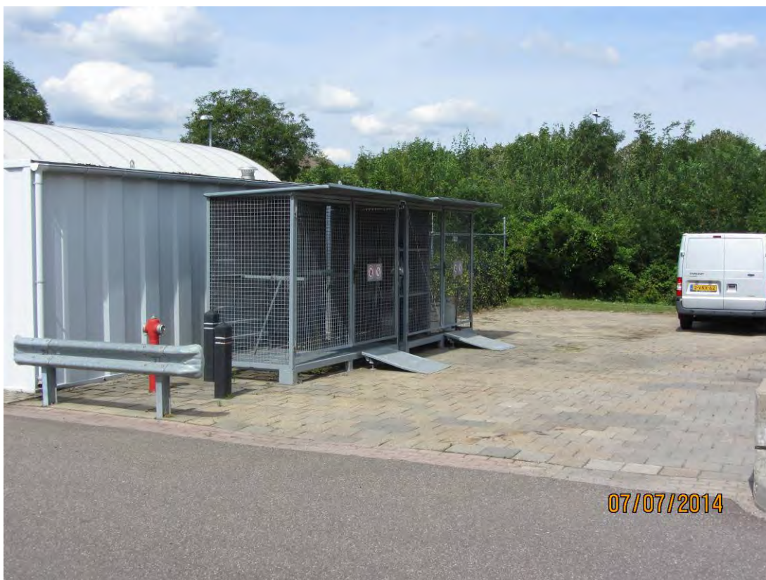
Parkeerplaats met opslag gasflessen.
