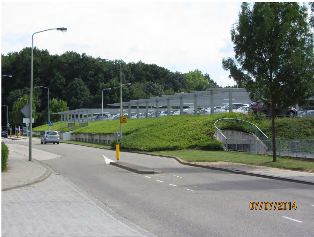
Henri Dunantstraat (zicht op parkeergarage).
