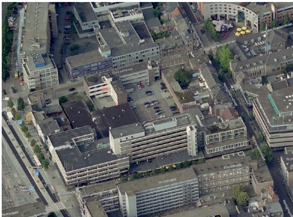
Luchtfoto van de feitelijke situatie voorafgaand aan de sloop die in 2019 heeft plaatsgevonden (bron: Bing)
