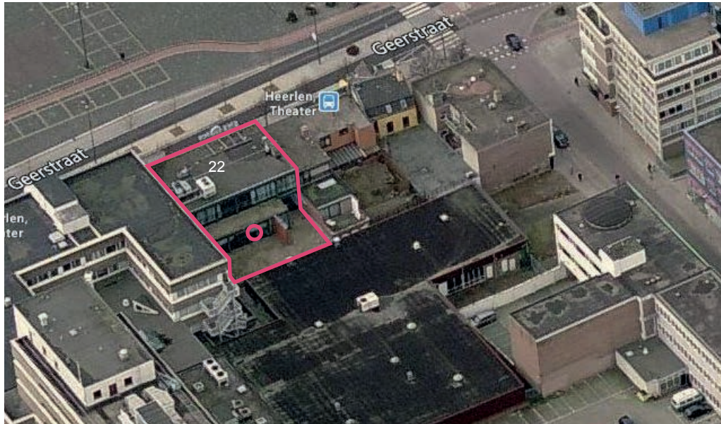
Aanduiding Geerstraat 22 en meetpunt (bron: Bing)
