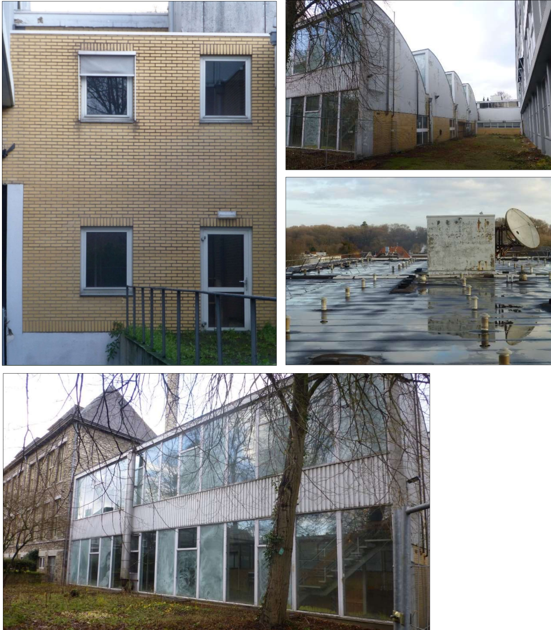
Figuur 2 - 5 met de klok mee: Gevel 'doorloop' tussen beide te slopen delen van het gebouw, deel met karakteristieke daken, zicht op het dak en foto van de zijgevel oostzijde van het te slopen pand grenzend aan het te behouden deel.
