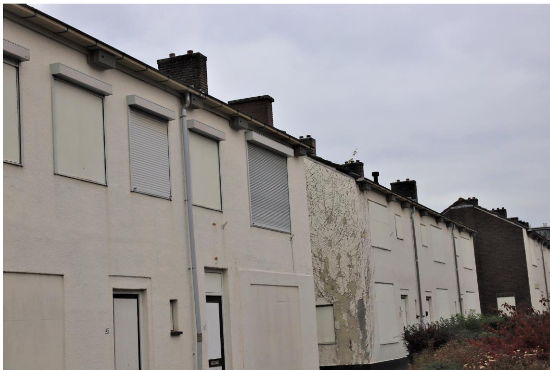
Foto 2: vooraanzicht van de woningen met een deel van de geplaatste gierzwaluwkasten, onder de dakgoten
