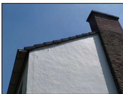
Figuur 13. Overhangende dakpannen.
