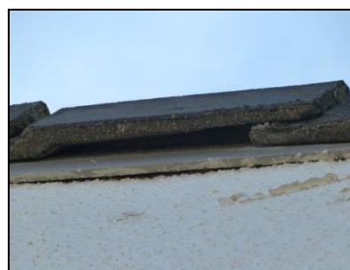
Figuur 14. Openingen langs dakrand.
