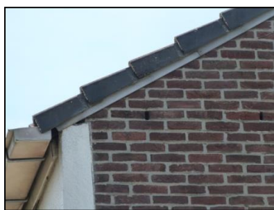
Figuur 12. Open stootvoegen
