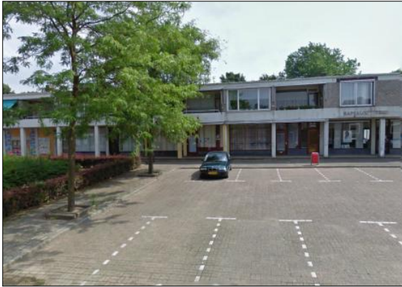
Figuur 2. Woningen aan de Amsterdamstraat 58-66.
