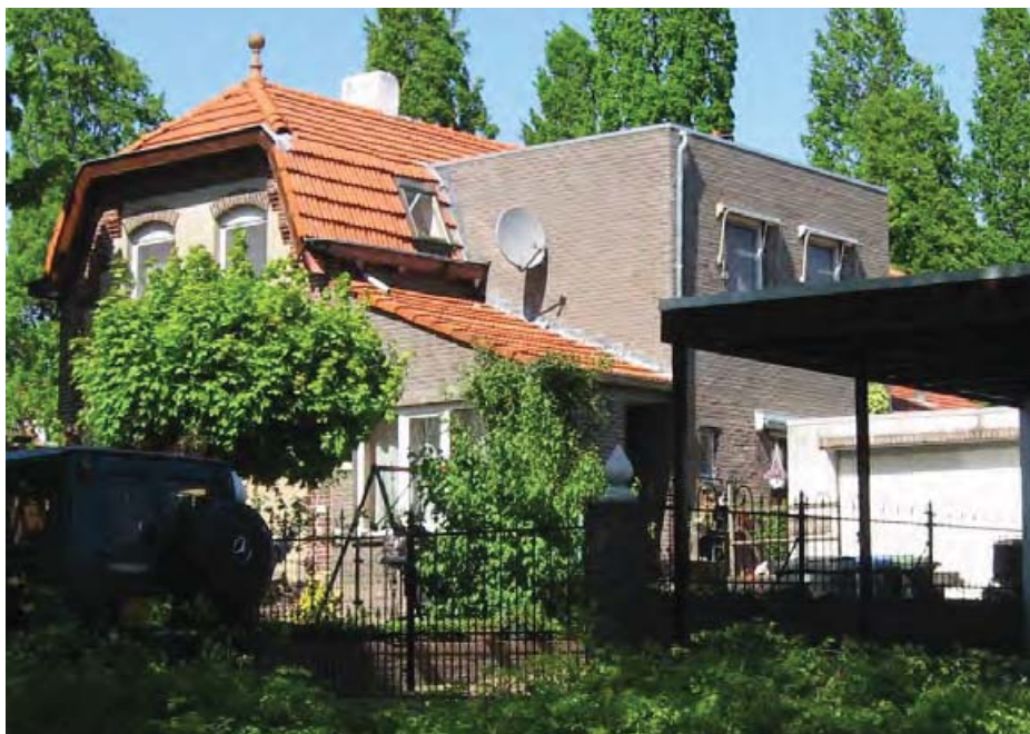
bestaande situatie twee-onder-één-kap woningen (andere dakpannen en baksteen)
