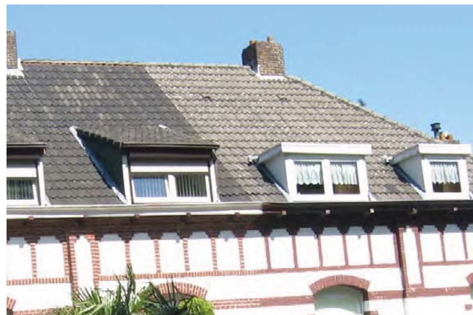
verschillende typen dakkapel en kleur dakpannen
