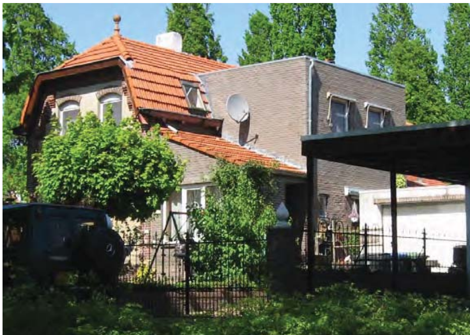
bestaande situatie aanbouw in 2 bouwlagen
