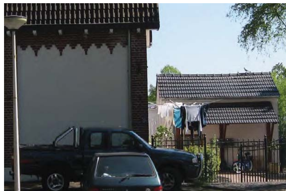
bestaande situatie bijgebouw
