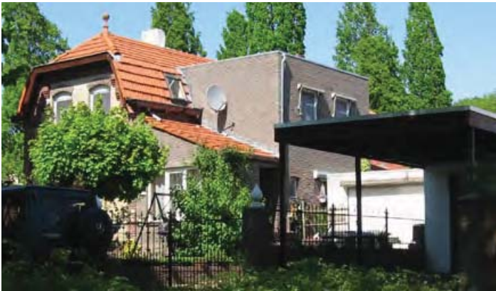
2 laagse aanbouw achterzijde twee-onder-één-kap woningen
