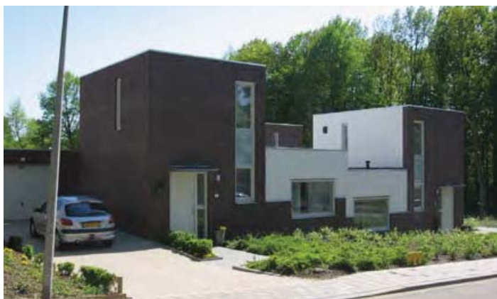
recente nieuwbouw Scheldestraat
