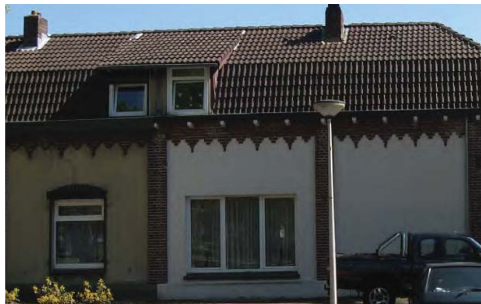
bestaande situatie twee-onder-één-kap woningen (kleurverschillen stucwerk)
