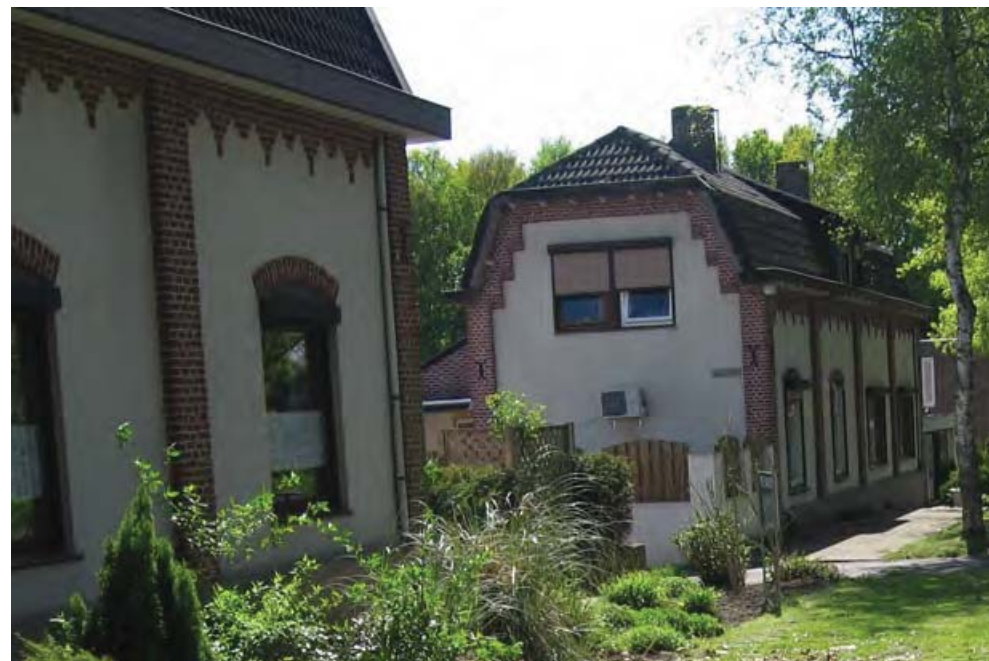
bestaande situatie twee-onder-één-kap woningen (rolluiken en andere dakgoten)
