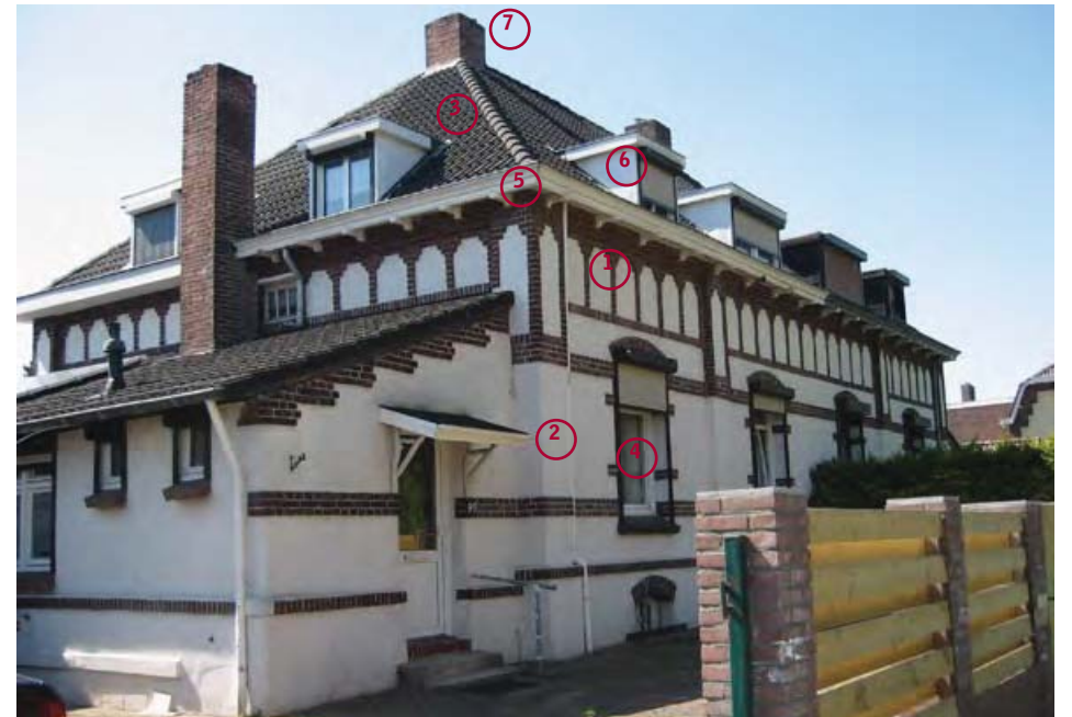
grotendeels originele gevelindeling rug-aan-rug woning
