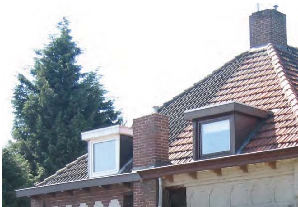
verschillende typen dakkapel en kleur dakpannen
