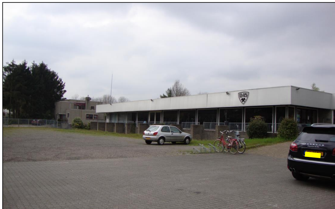
Voorgevel van het pand Jeugrubbenweg 20
