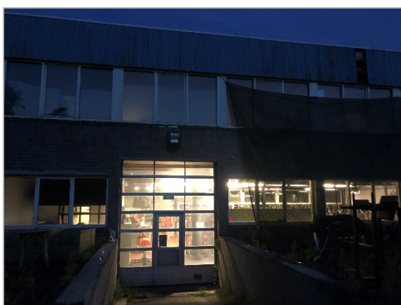
Figuur 22 Souterrain, garagedeur gesloten
