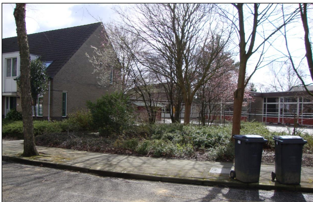
De woningen aan de Mgr. Feronlaan grenzen in de bestaande situatie direct aan de buitenspeelplaats van de school
