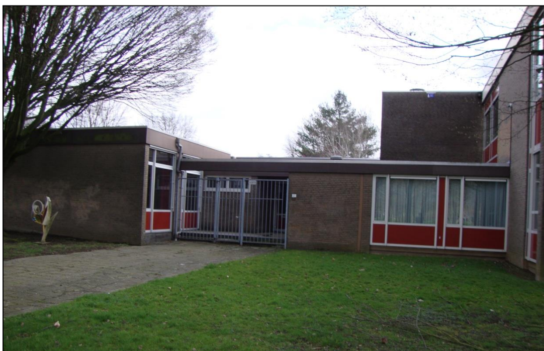
De westelijke ingang van het bestaande onderwijsgebouw (Dr. A. Schweitzer school)
