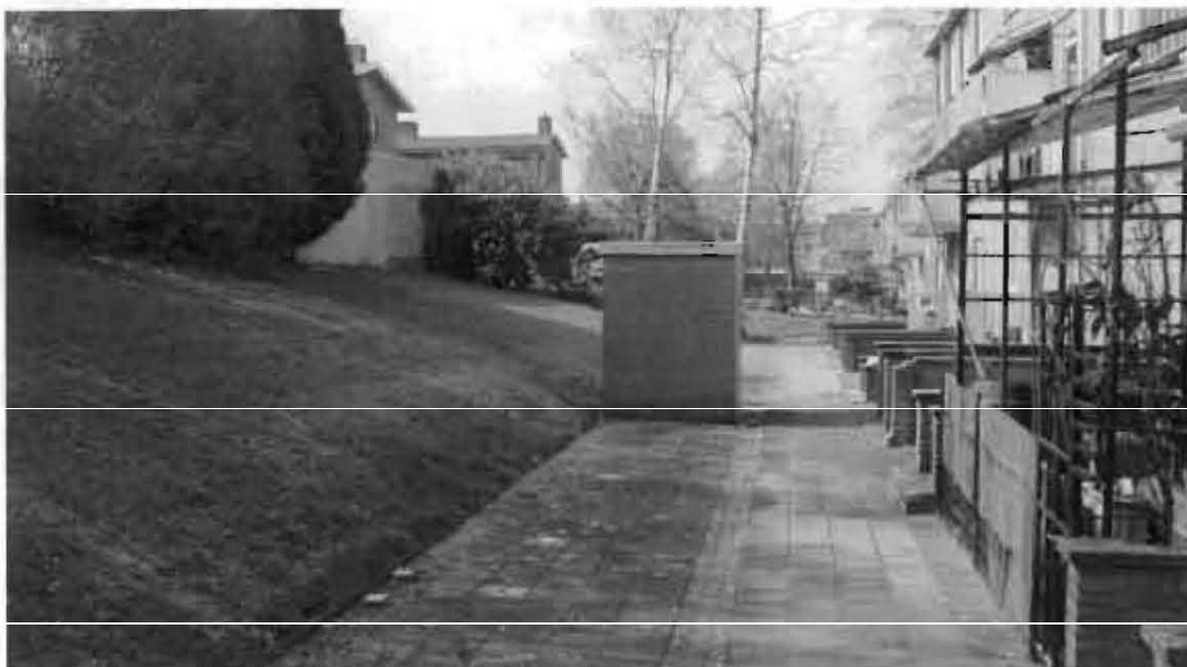
Foto 12: Achterzijde Bakkerstraat 38 t/m 66.
