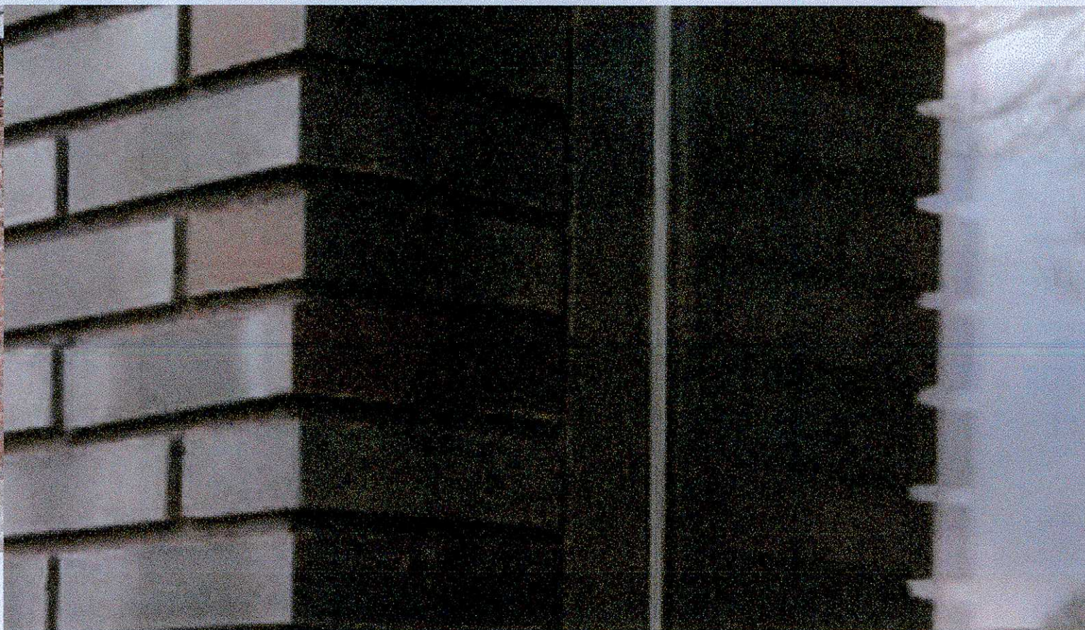
voorbeeld van kozijn achter metselwerk
