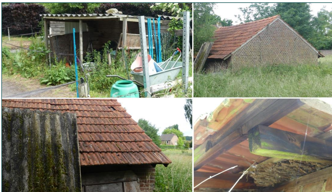
Figuur 3.1 Fotografische indruk van de bebouwing op de planlocatie met de schuur in deelgebied A (linksboven) en de schuur in deelgebied D met afgedichte kopgevels (rechtsboven) en een lage dakconstructie, waarvan de ingangen zijn afgedicht met het rieten dakbeschot (onder)
