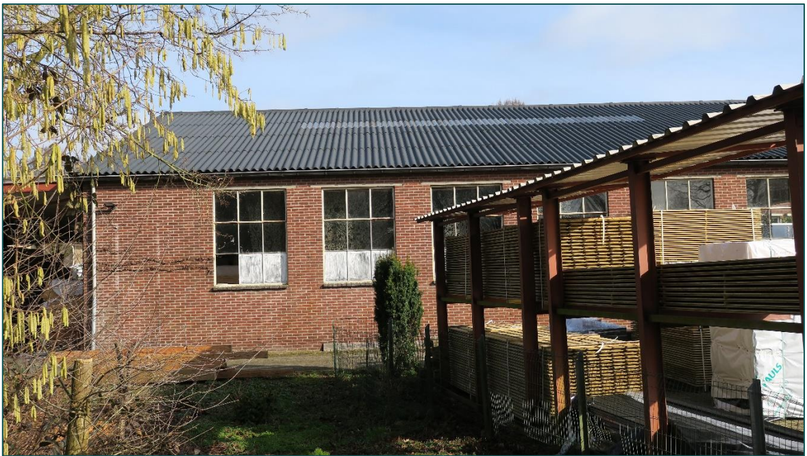
Figuur 4 Onder het dak van de loods zijn mogelijk nestlocaties van de huismus aanwezig.
