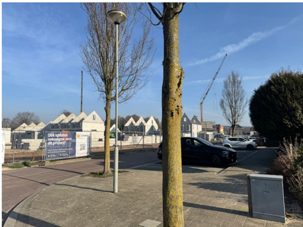
• Afbeelding 5: Plan 'Heiveld', ten zuidoosten van de projectlocatie, volop in aanbouw
