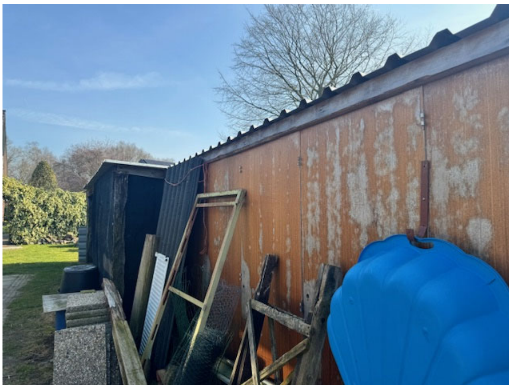
• Afbeelding 12: voorzijde te slopen bijgebouw/overkapping
