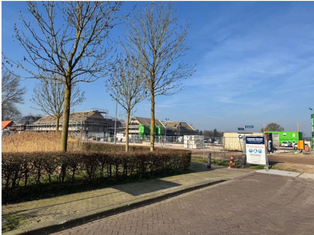
• Afbeelding 4: Plan 'Heiveld', ten zuidoosten van de projectlocatie, volop in aanbouw
