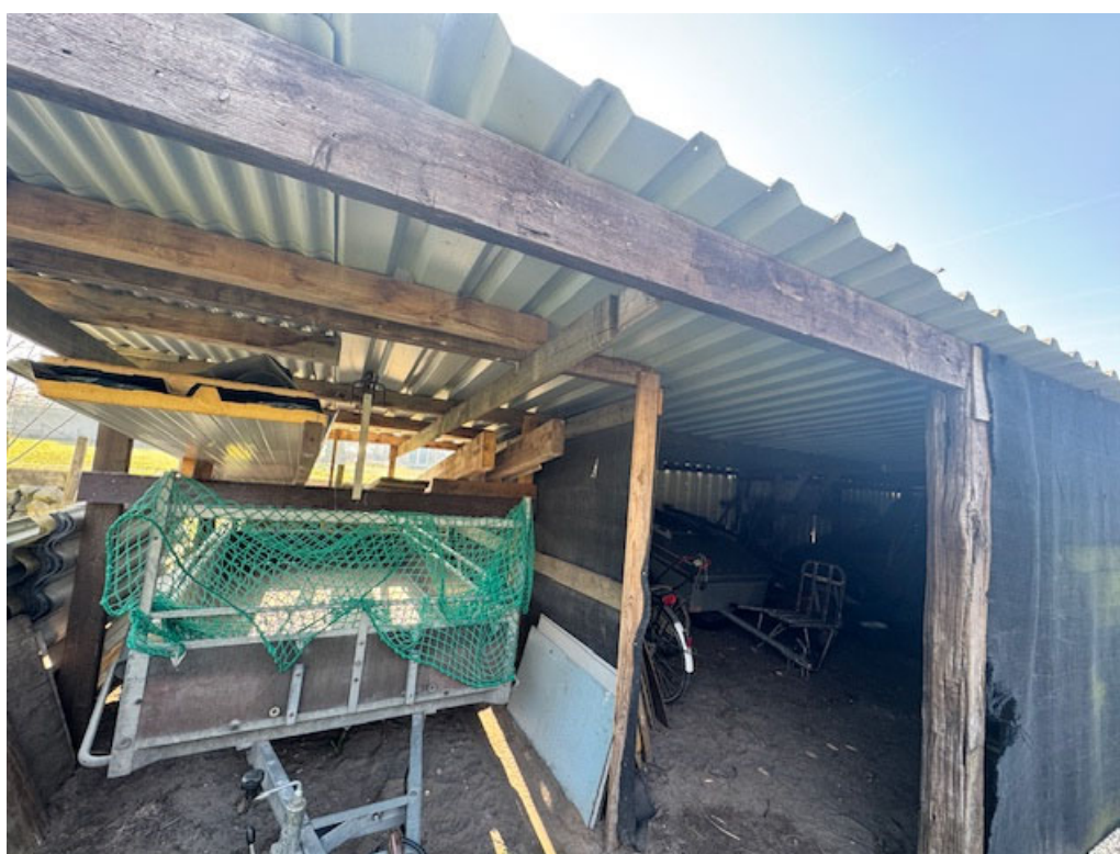
• Afbeelding 13: binnenzijde te slopen overkapping
