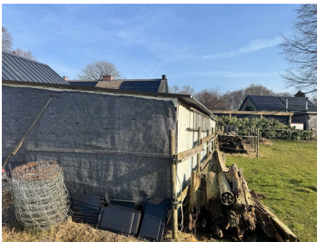
• Afbeelding 11: te slopen bijgebouw/overkapping
