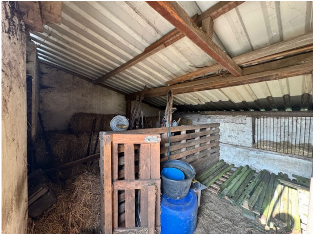
• Afbeelding 25: binnenzijde paardenstal
