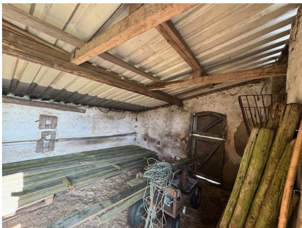
• Afbeelding 24: binnenzijde paardenstal
