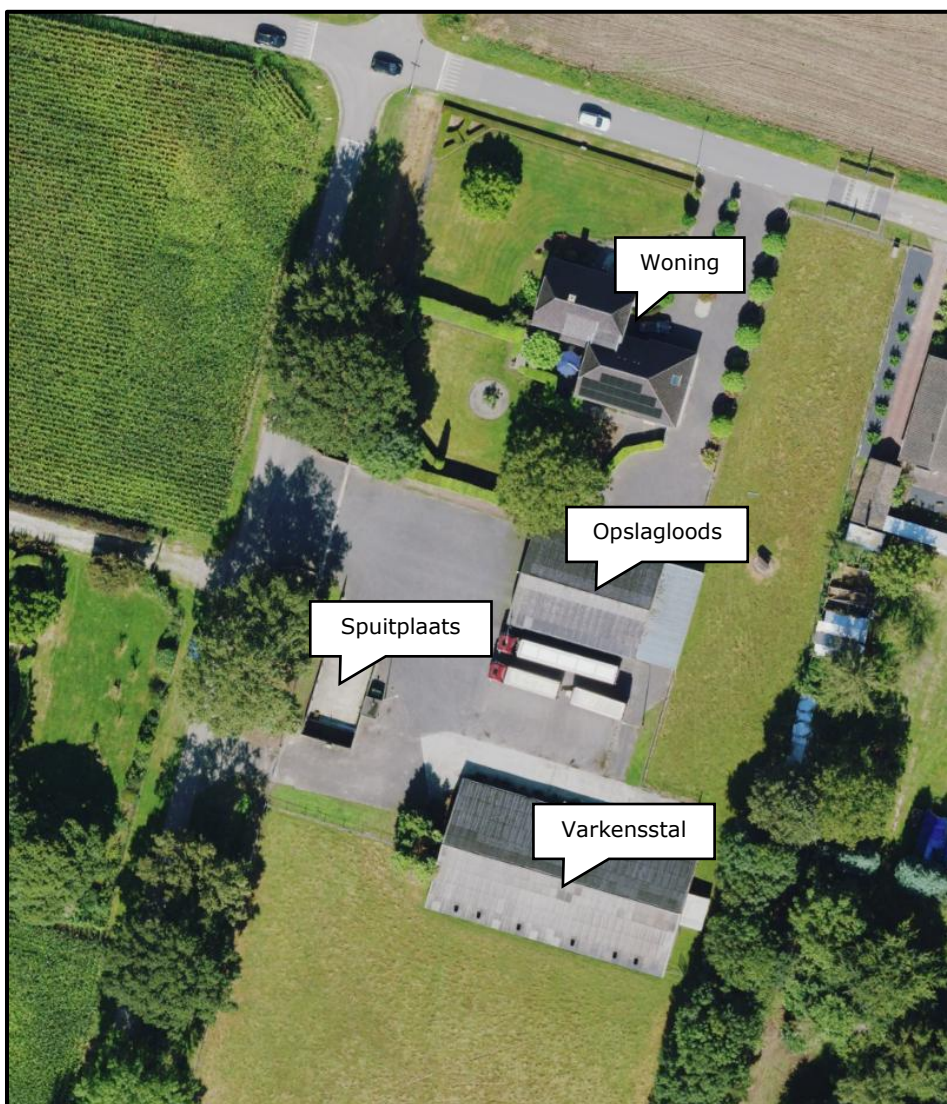
Afbeelding 4. Luchtfoto huidige situatie plangebied.
