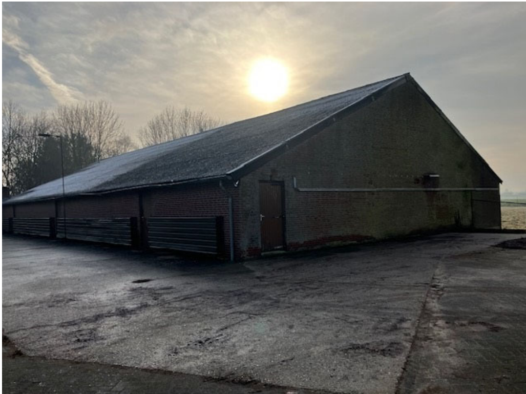
• Afbeelding 6: te slopen stal
