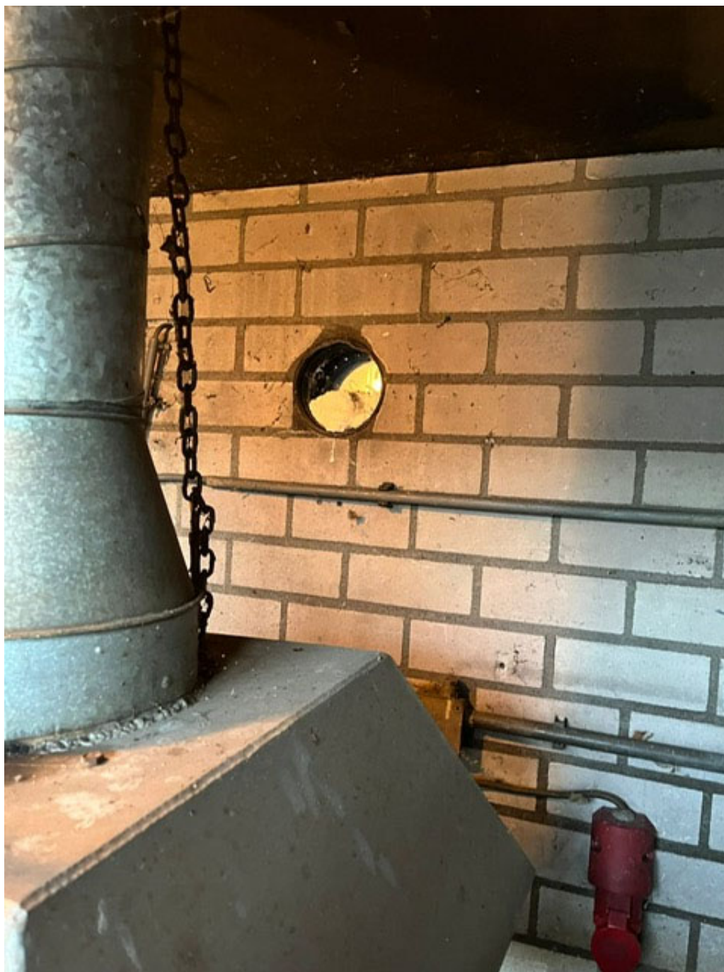
• Afbeelding 13: binnenzijde gebouw naast wasplaats
