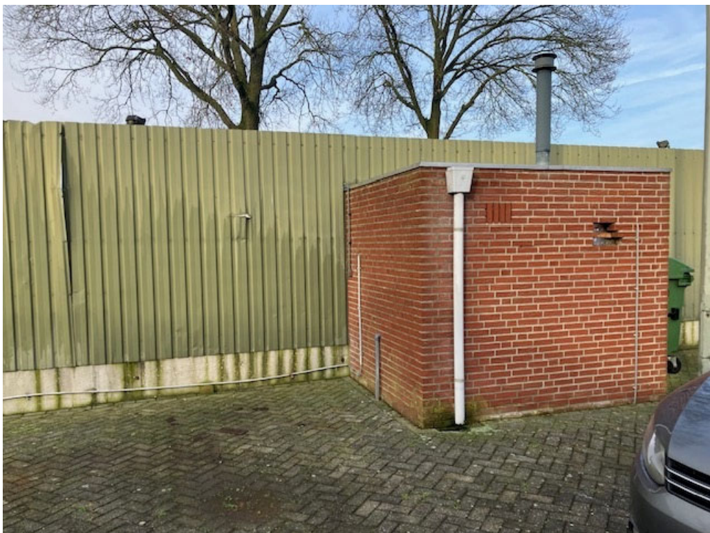
• Afbeelding 7: wasplaats achter de damwand
