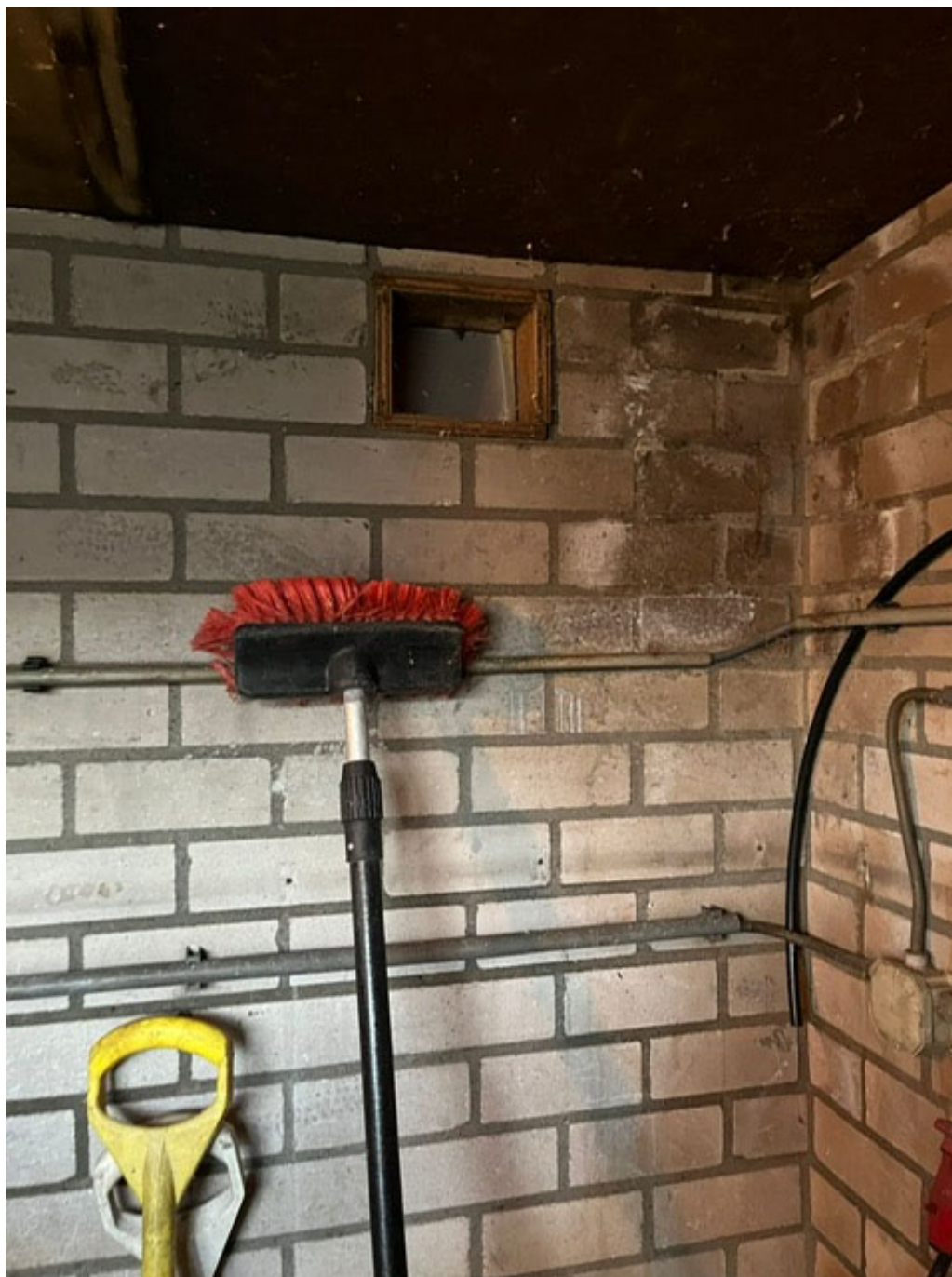
• Afbeelding 14: binnenzijde gebouw naast wasplaats
