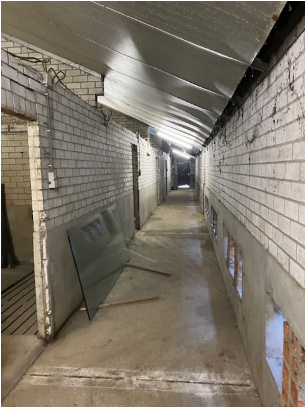
• Afbeelding 8: binnenzijde te slopen stal, volledig gestript
