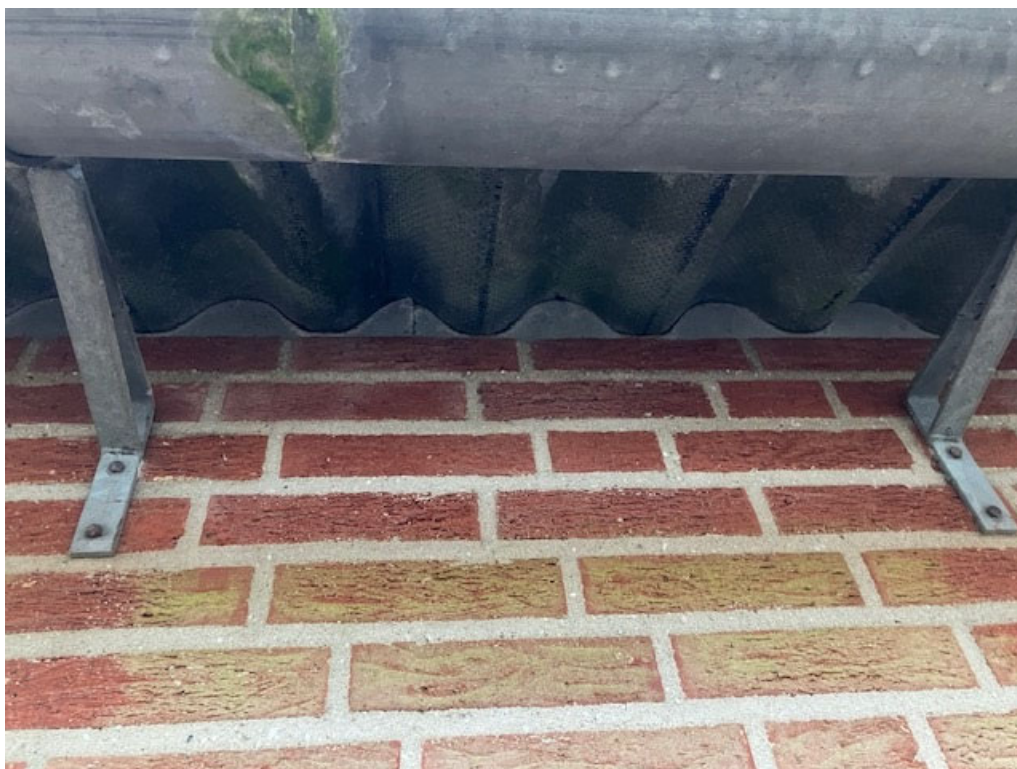
• Afbeelding 10: onderzijde dakplaten dicht gezet met vogelschroot
