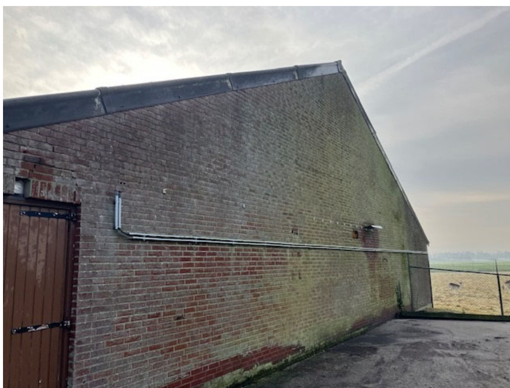
• Afbeelding 11: achtergevel te slopen stal, op de achtergrond een weide met hertjes
