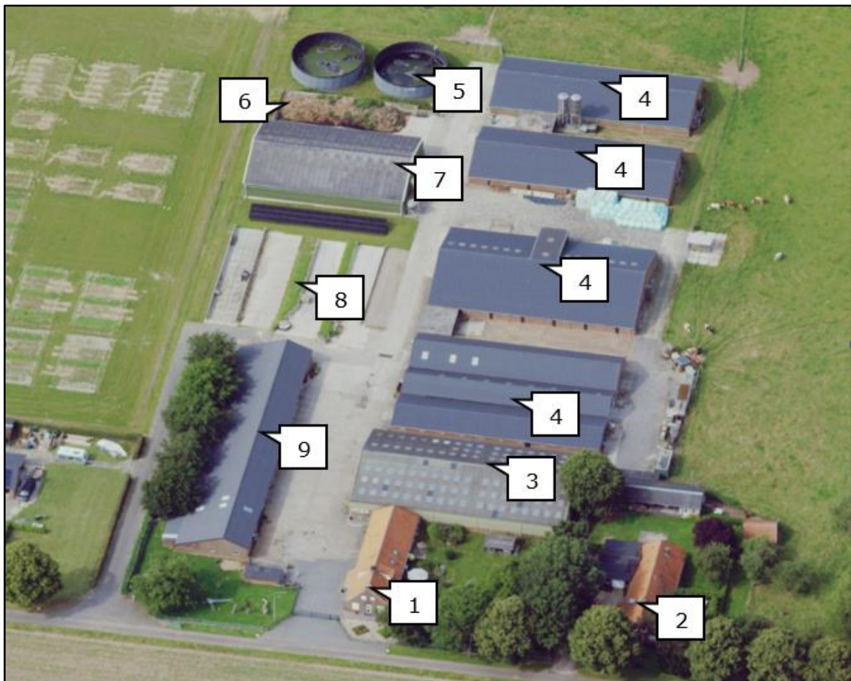
Afbeelding 5. Luchtfoto huidige situatie plangebied
