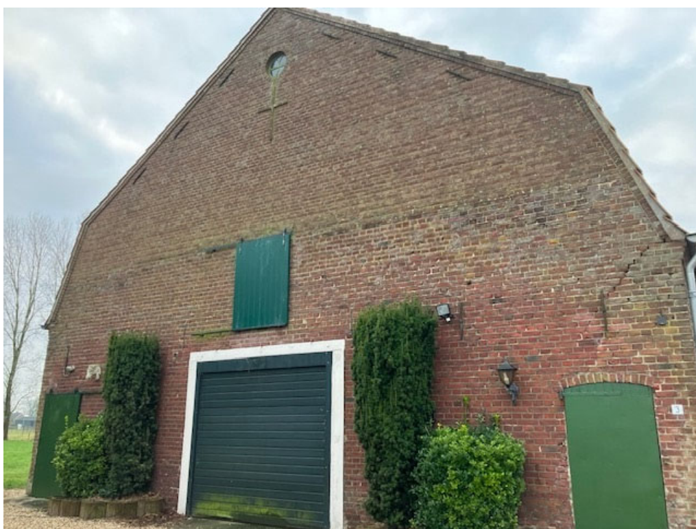
• Afbeelding 19: voorgevel schuur die tot 3 woningen verbouwd wordt
