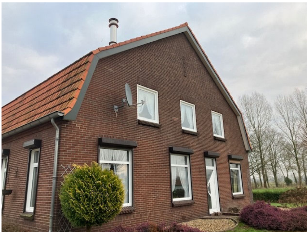
• Afbeelding 10: achtergevel, woonhuis
