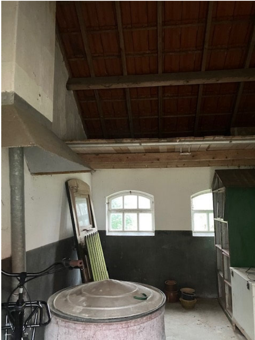
• Afbeelding 15: binnenzijde te verbouwen schuur
