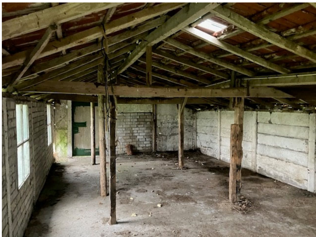
• Afbeelding 21: binnenzijde te behouden bijgebouw (kippenhok)
