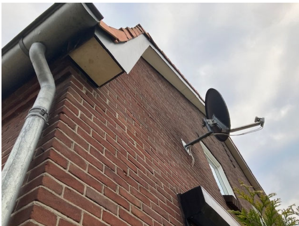
• Afbeelding 12: Detail onderzijde overstek en dakgoot
