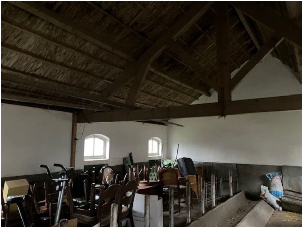
• Afbeelding 14: binnenzijde tweede schuur waarin 1 woning gemaakt wordt
