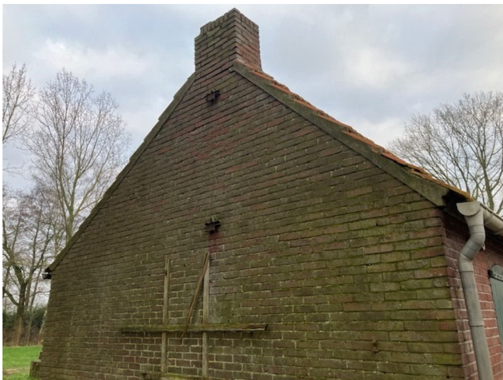
• Afbeelding 16: achtergevel te behouden bijgebouw
