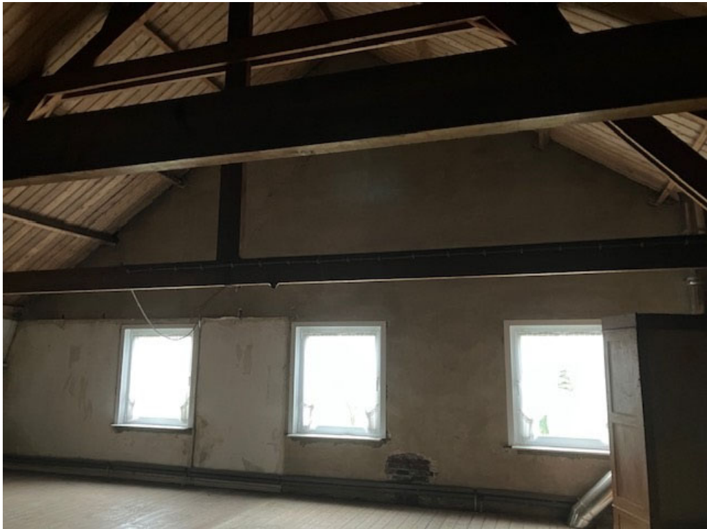
• Afbeelding 6: zolder boven het woonhuis
