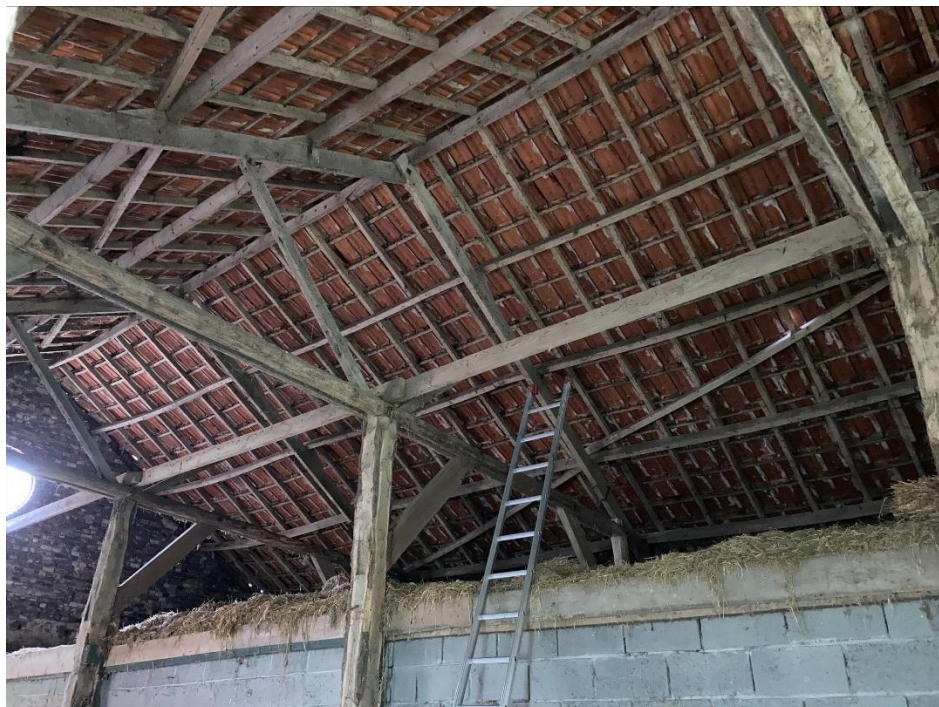
Constructie en dak
