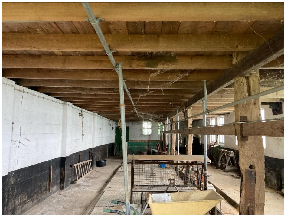
Gedeelte voor de koeien richting westgevel
