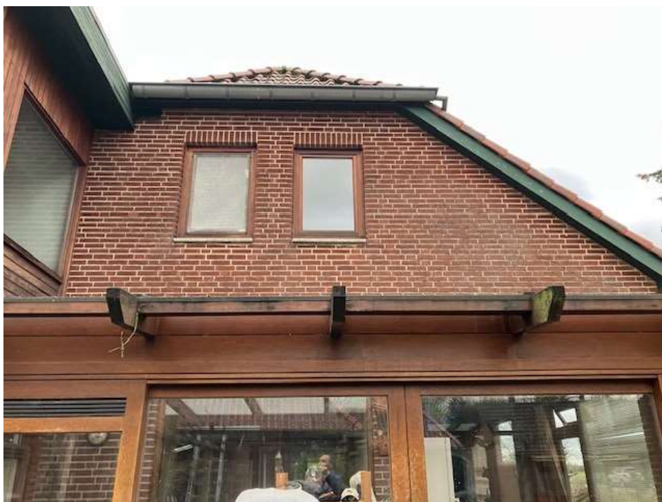
• Afbeelding 28: achtergevel woning, blijft geheel in tact
