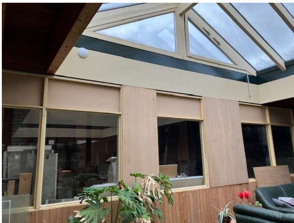
• Afbeelding 5: Binnenzijde zwembad, wordt gesloopt
