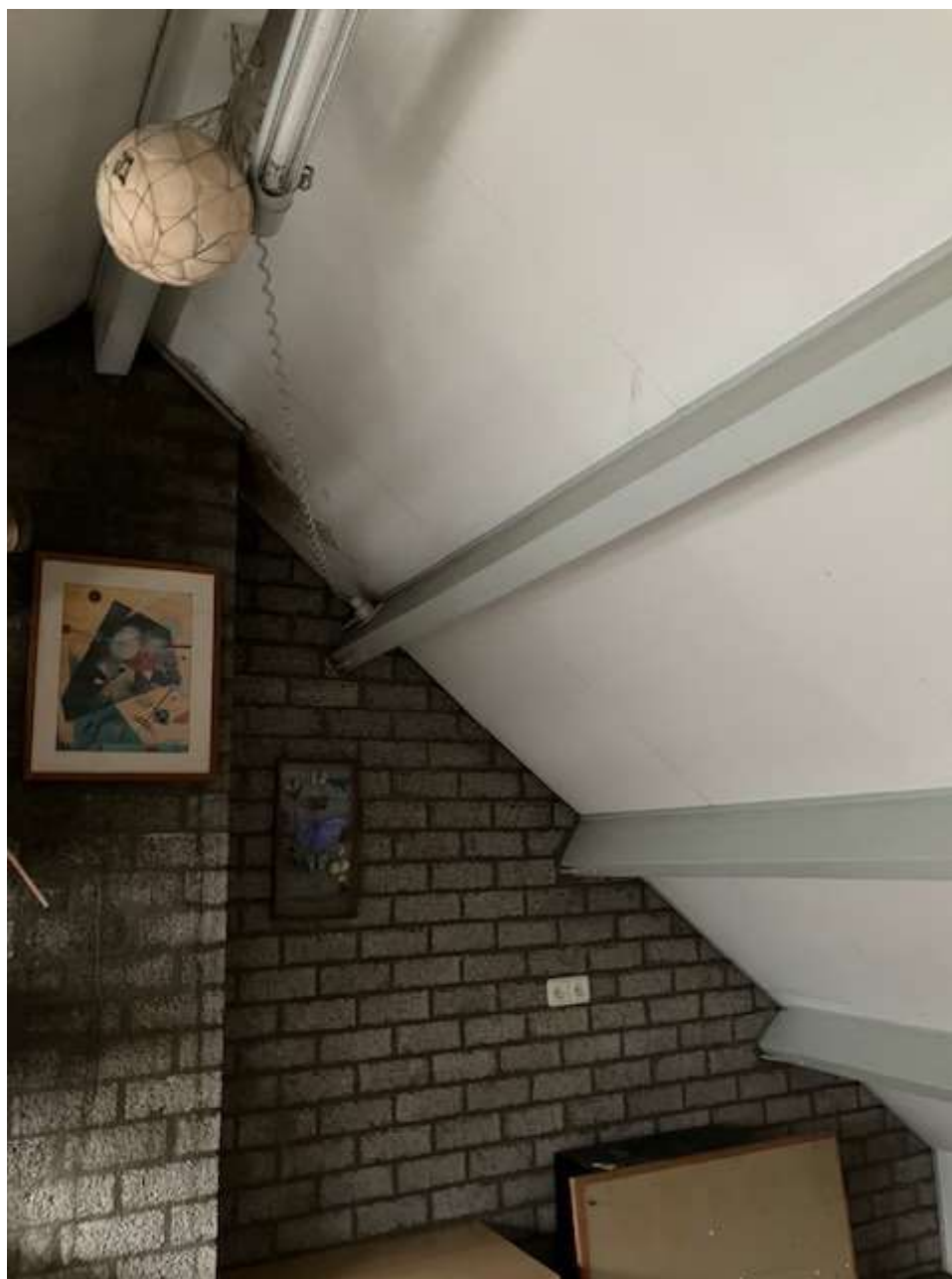
• Afbeelding 22: ruimte in te slopen bouwdeel tussen woning en appartementen
