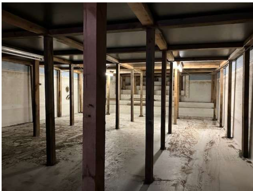
• Afbeelding 17: voormalig binnenzwembad deze wordt gesloopt
