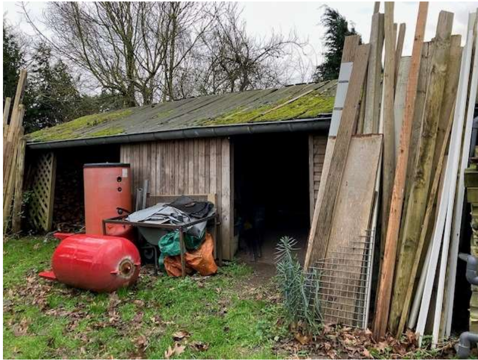
• Afbeelding 13: mogelijk wordt dit gebouw gesloopt
