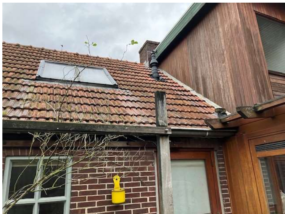
• Afbeelding 27: links te slopen bouwdeel tussen woning en appartementen, rechts een houten opbouw op de woning, blijft behouden
