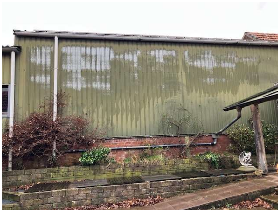
• Afbeelding 9: damwand bedrijfshal van de buren
