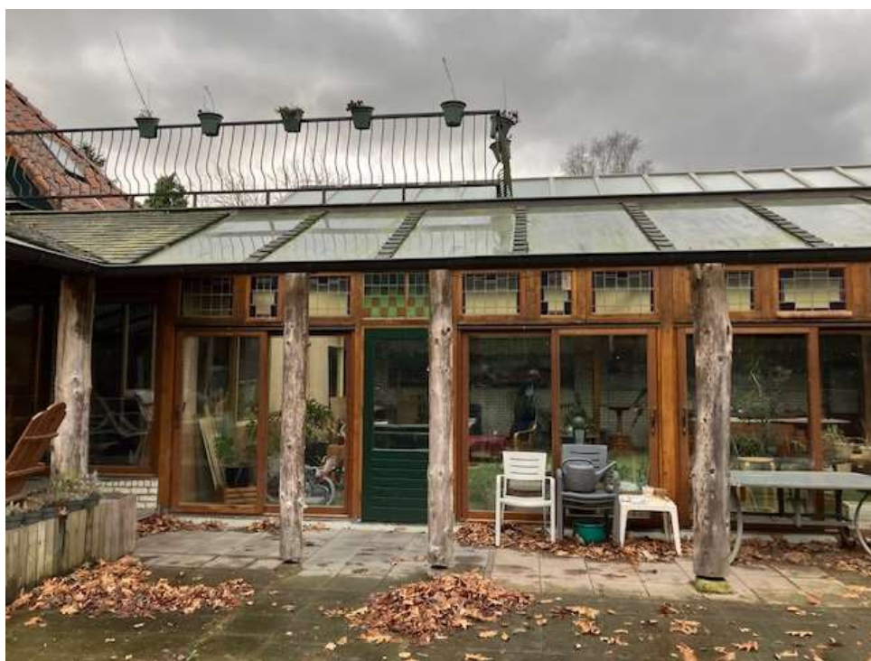
• Afbeelding 6: gevel zwembad, wordt gesloopt
