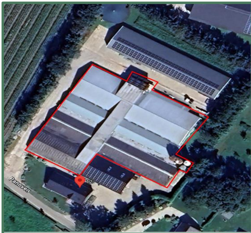
Afbeelding 3: Te slopen bebouwing rood omlijnd. Bron: Wouters Odiliapeel B.V.
