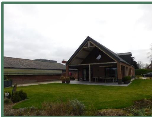
Afbeelding 7: Woonhuis vanaf het westen
