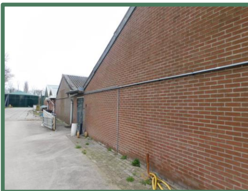
Afbeelding 9: Zijgevel van de varkenstallen vanaf het zuidwesten
