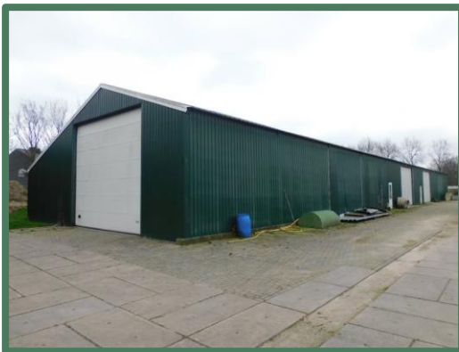
Afbeelding 16: Loods vanaf het westen
