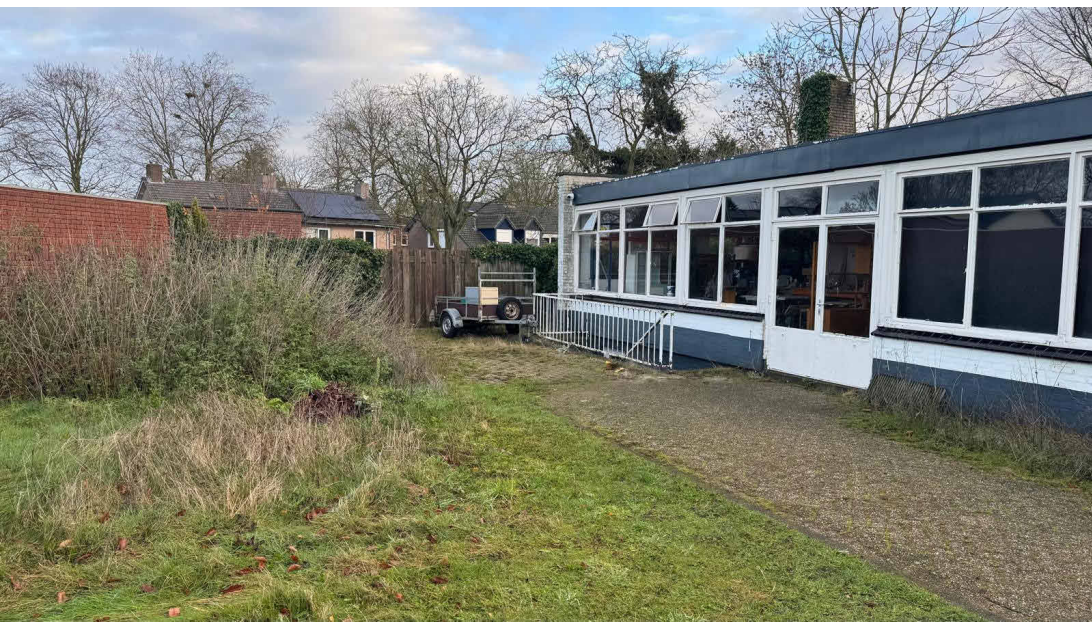
4 noord-west hoek perceel
