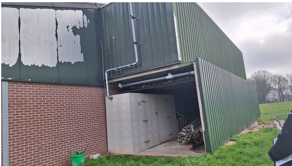
Foto 15: Zuidelijke gevel varkensstal 3
