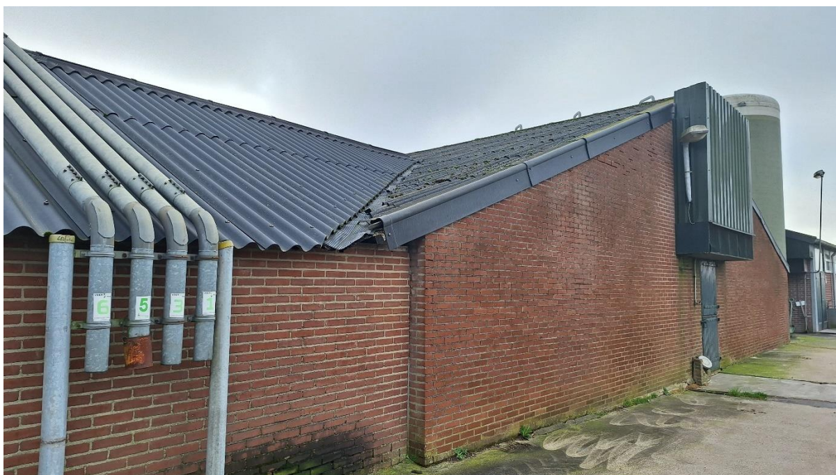
Foto 13: Zijaanzicht gevel varkensstal 2 (westelijke gevel)
