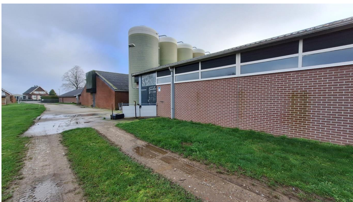
Foto 14: Zijaanzicht gevel varkensstal 3 (westelijke gevel)
