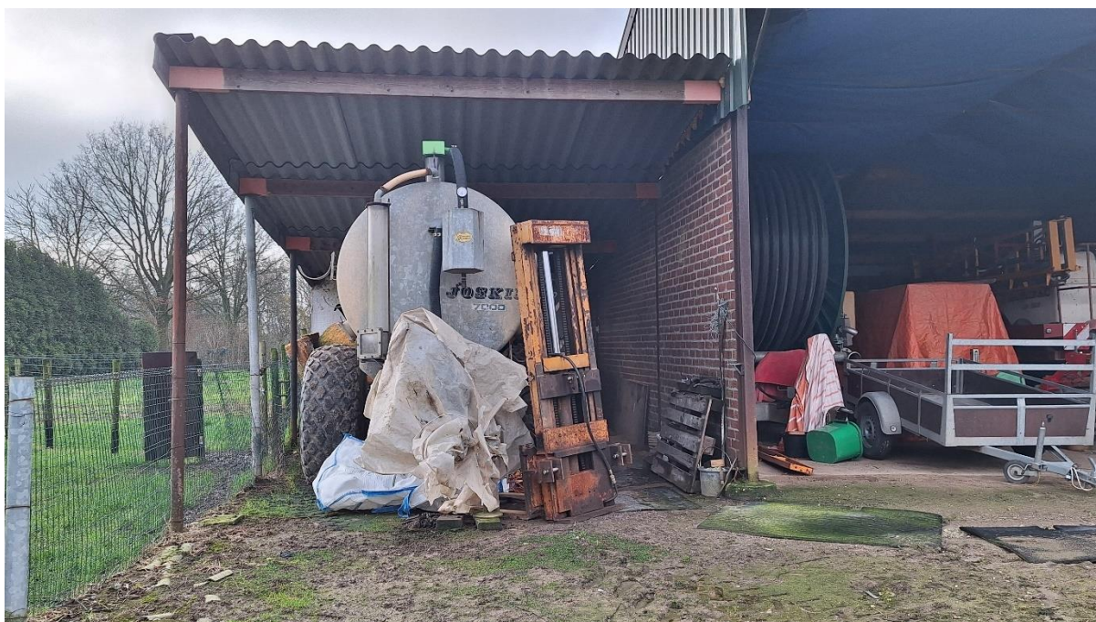
Foto 9: Overkapping en kapschuur
