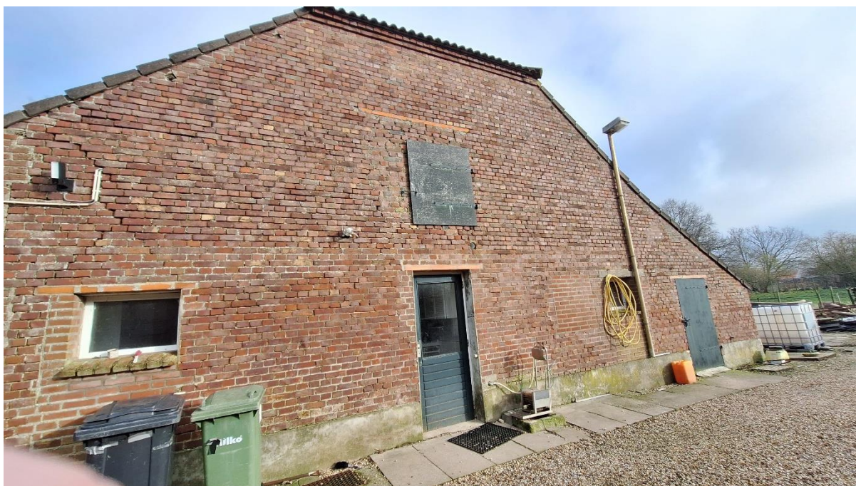
Foto 3: Zuidelijke kopgevel woonhuis
