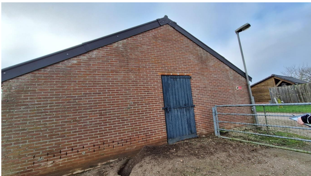
Foto 11: Kopgevel varkensstal 1 (noordelijke zijde)
