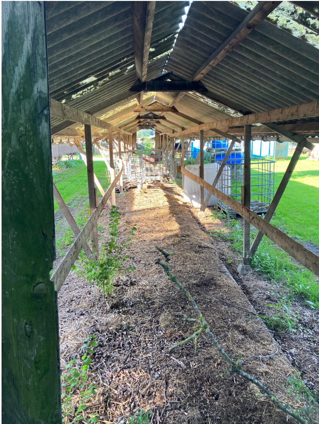
• Afbeelding 17: onderzijde shed
