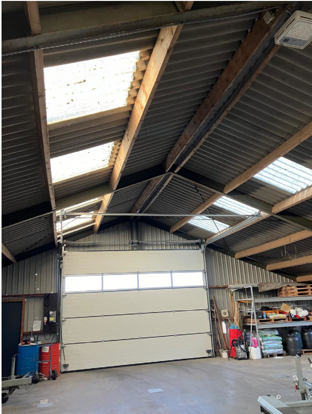
• Afbeelding 22: Binnenzijde loods blijft behouden
