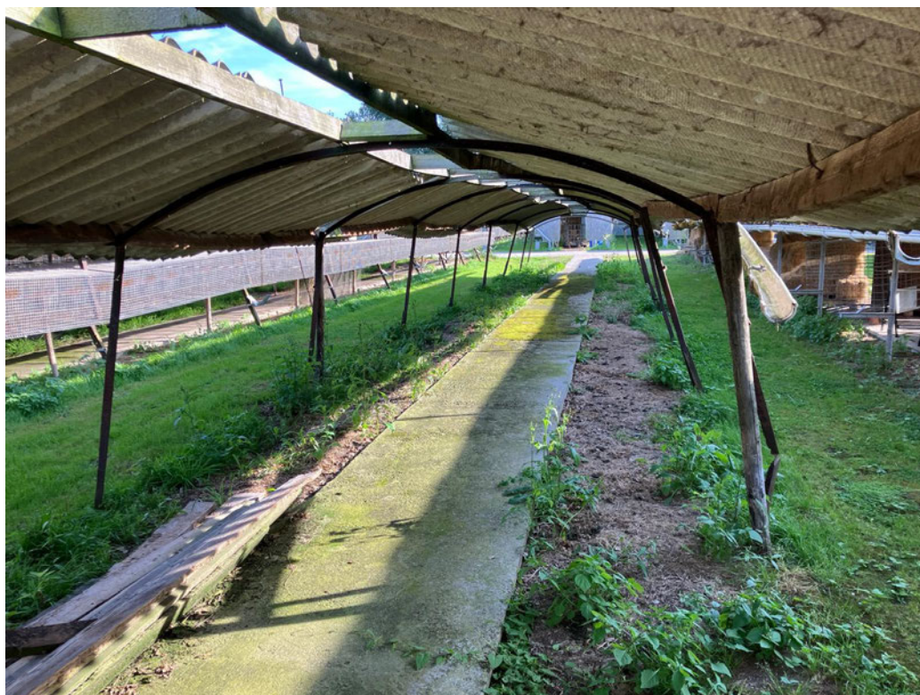
• Afbeelding 18: Onderzijde shed
