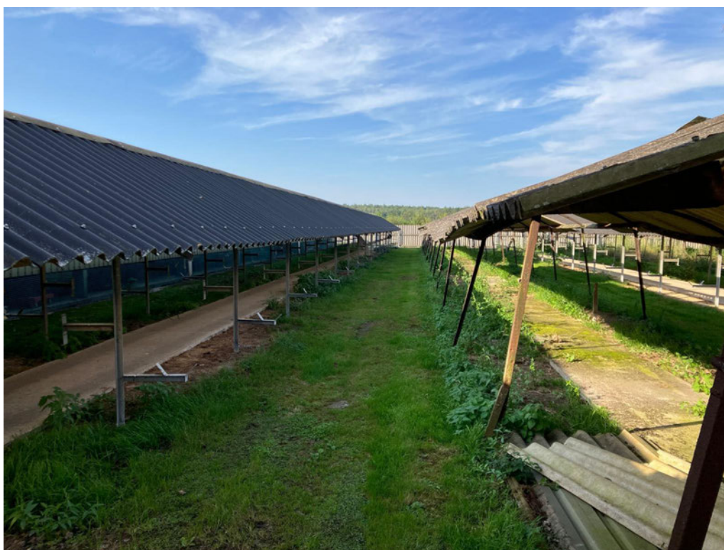
• Afbeelding 15: ruimte tussen twee sheds
