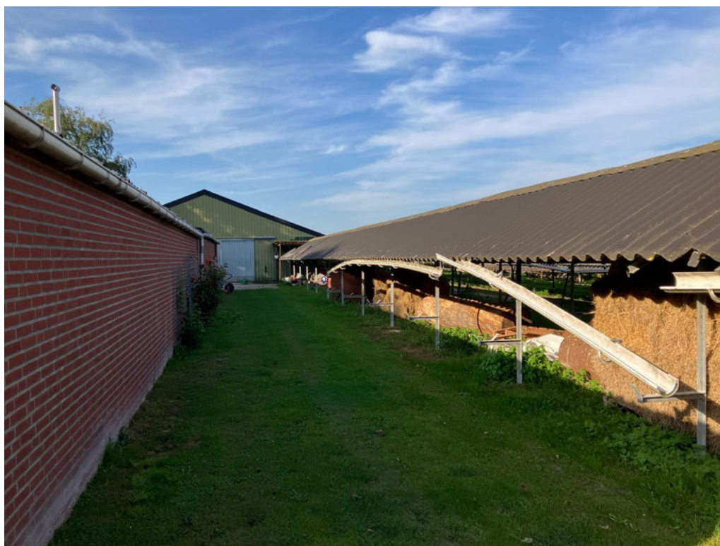
• Afbeelding 19: ruimte tussen een shed en een te behouden loods met zicht op een andere te behouden loods
