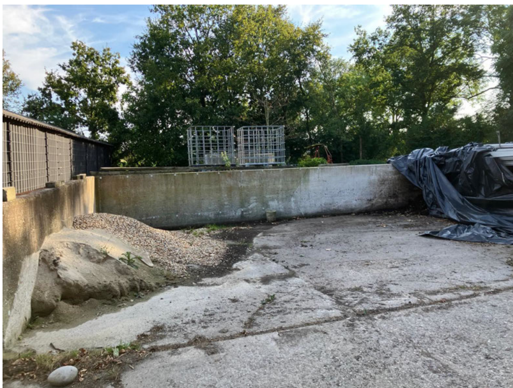
• Afbeelding 13: voormalige kuilplaten worden verwijderd
