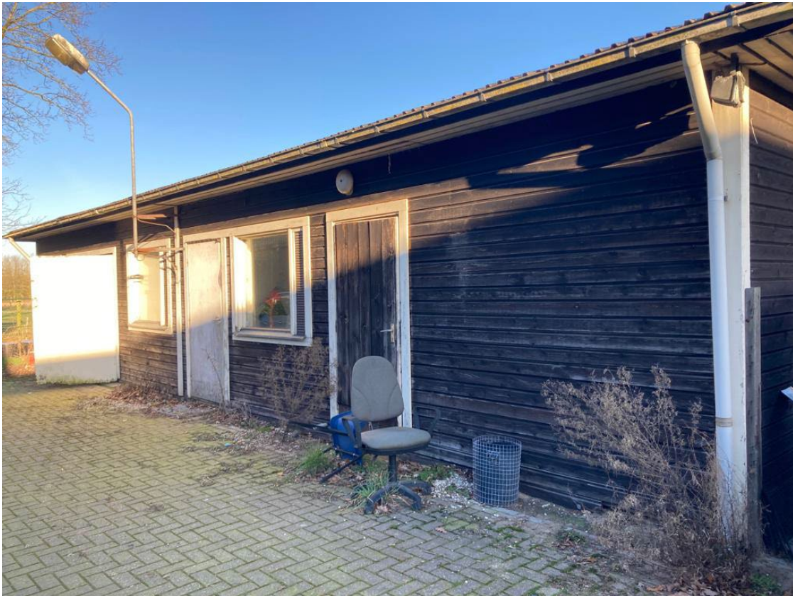
• Afbeelding 12: houten voormalige kantine wat wordt gesloopt
