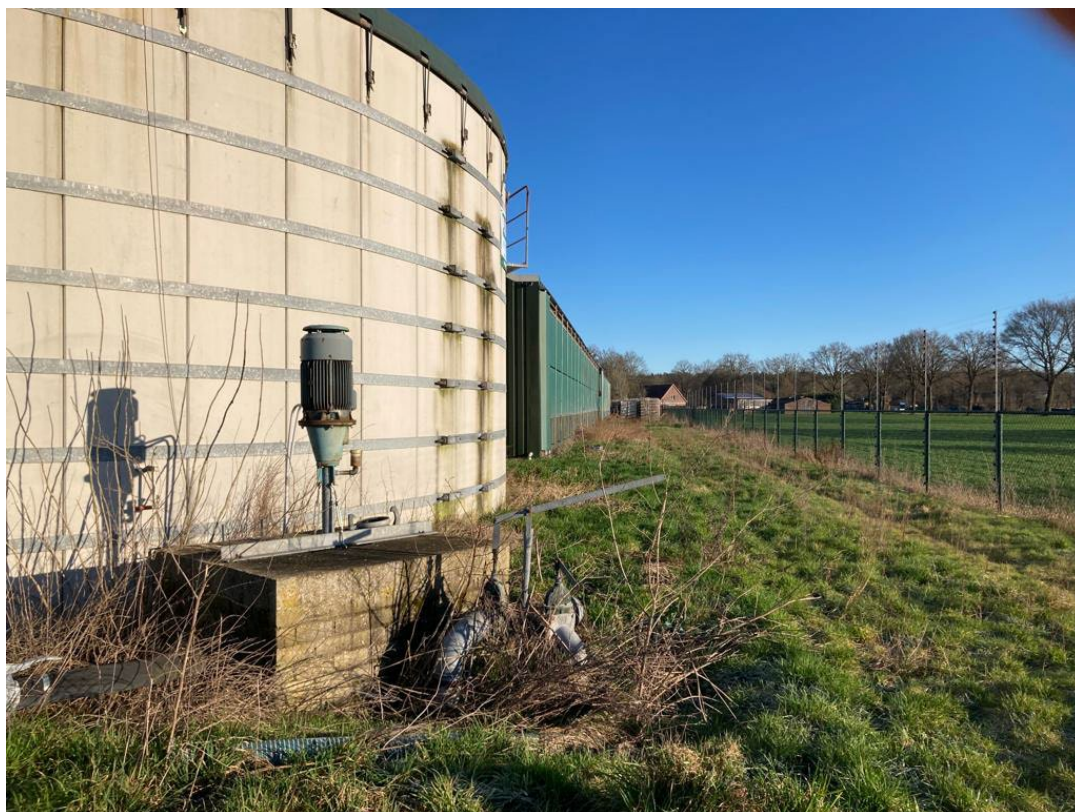
• Afbeelding 19: voorzijde mestsilo en elektrisch hekwerk
