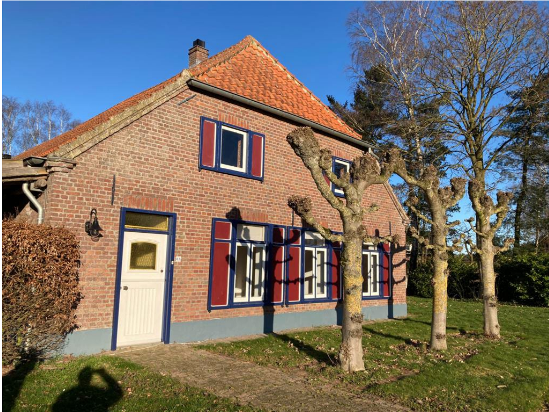
• Afbeelding 4: Voorgevel bedrijfswoning
