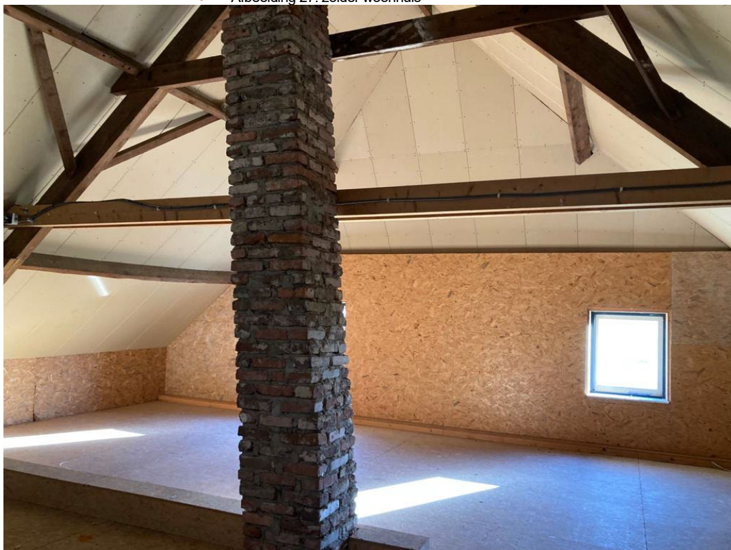
• Afbeelding 28: zolder woonhuis
