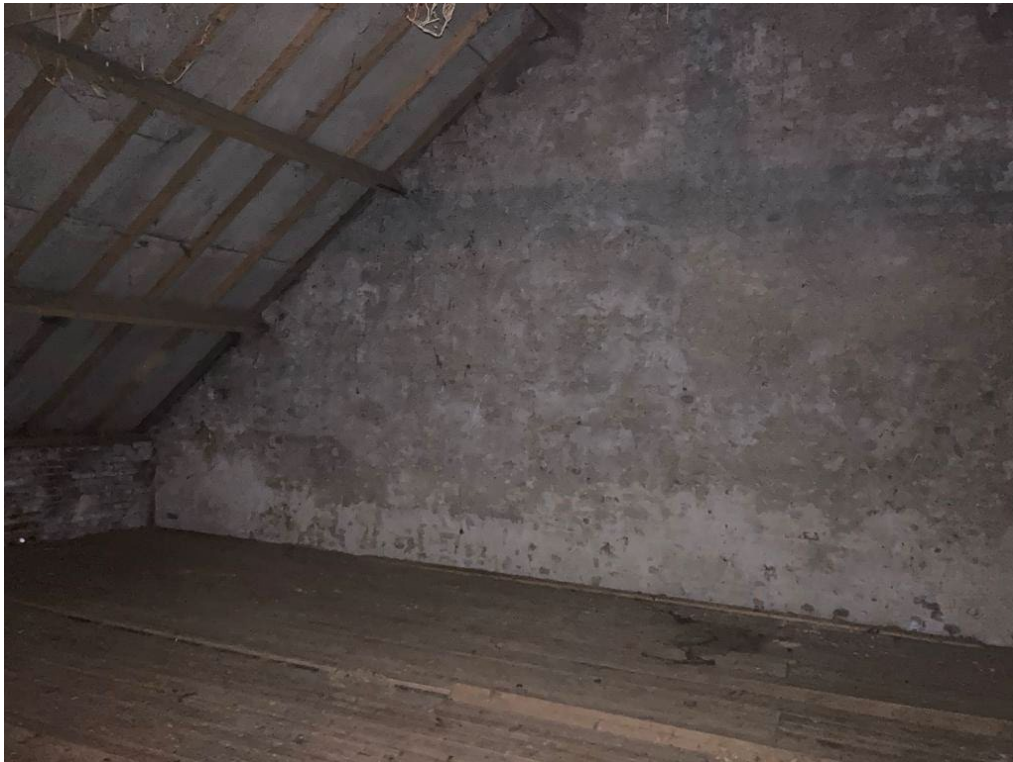
• Afbeelding 25: zolder paardenstal
