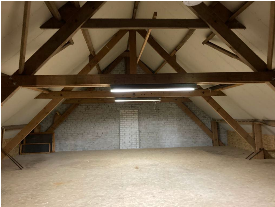
• Afbeelding 27: zolder woonhuis
