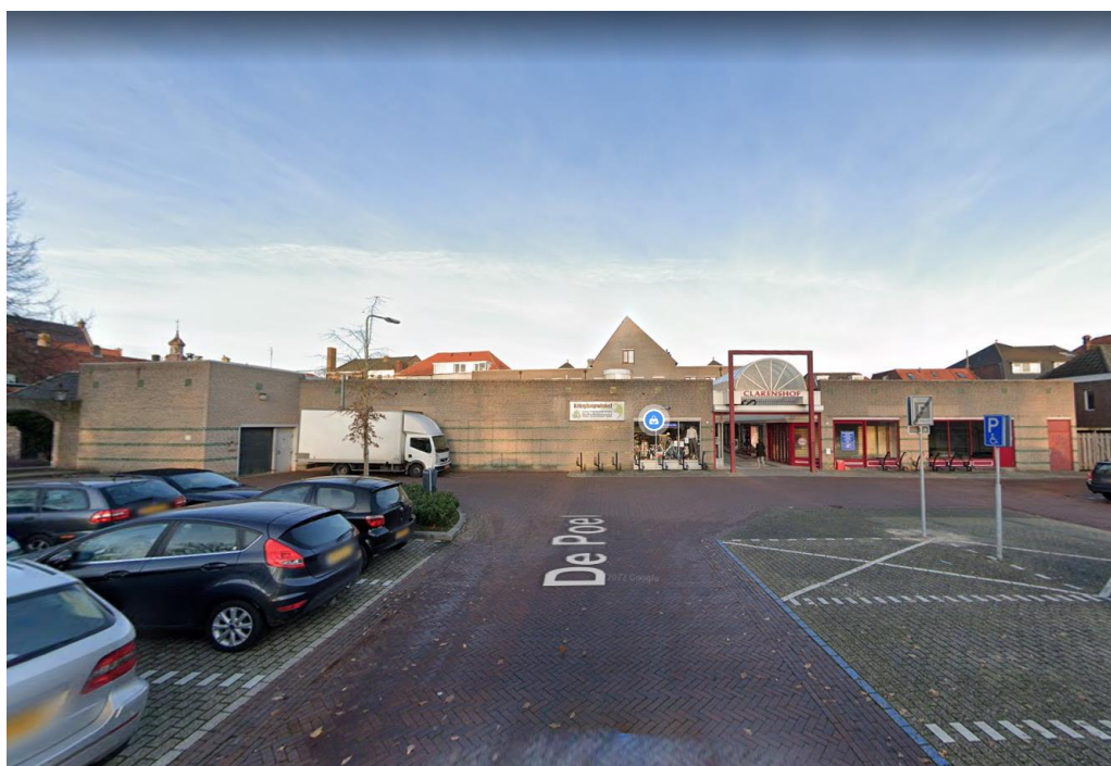
Figuur 4. (Tot voorkort) bestaande situatie besluitgebied. Zicht vanuit parkeerterrein aan De Poel.
