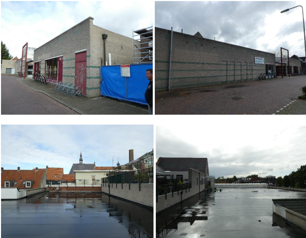
Afbeelding 3 t/m 6: De kavel met te slopen bebouwing welke bezocht en onderzocht zijn op de aanwezigheid van beschermde soorten flora en fauna. Bron: BNL advies, datum: 20-09-2022
