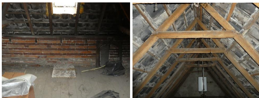
Afbeelding 12 en 13: Zandstraat 19-19a zonder dakbeschot en zonder aangetroffen nesten van de huismus. Bron: BNL advies, datum: 20-09-2022
