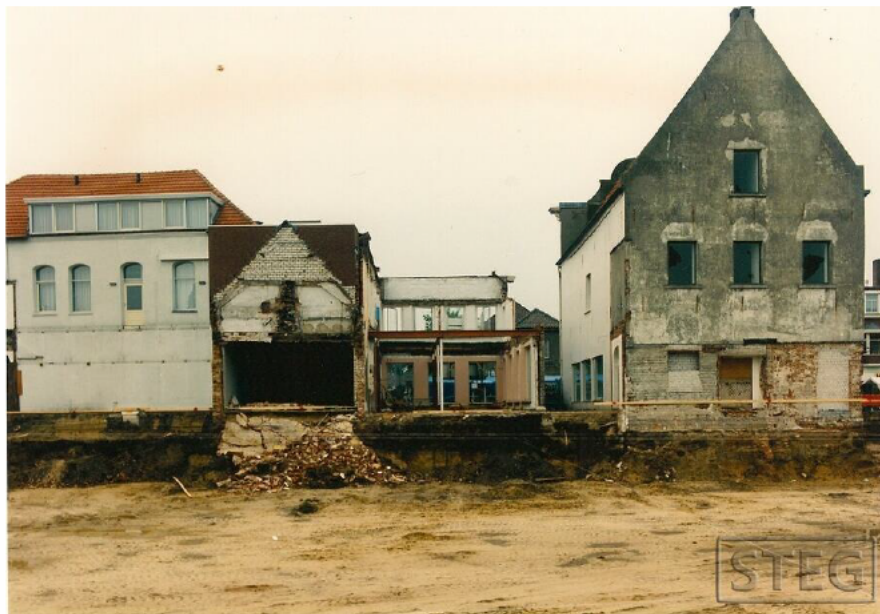
Afbeelding 3a: bouwterrein winkelcentrum Clarenshof, zicht vanaf de parkeerplaats de Poel/Zuidwal (bron foto: Stichting Erfgoed Genneep, 1992).
