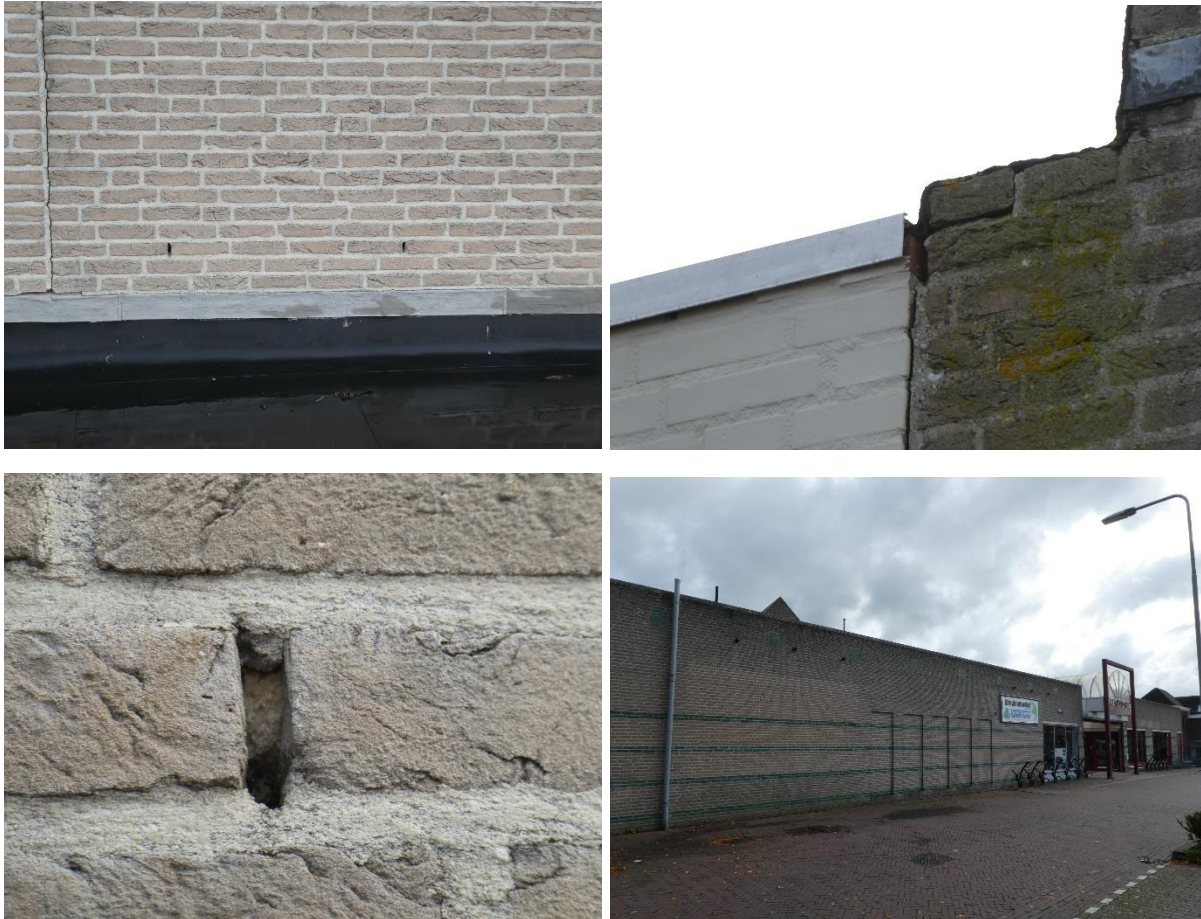
Afbeelding 18 t/m 21: geen geschikte openingen voor vleermuizen aangetroffen. Open stootvoegen zitten te laat of zijn afgesloten, daktrimmen sluiten voldoende aan en overige openingen in gevels en bij kozijnen zijn niet aangetroffen. Bron: BNL advies, datum: 20-09-2022
