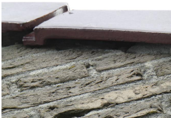
Afbeelding 22 en 23: Puntaken belegd met dakpannen zijn mogelijk geschikt voor vleermuizen om in via openingen bij dakpannen onder daken of in open spouwmuuren te komen. Bron: BNL advies, datum: 20-09-2022
