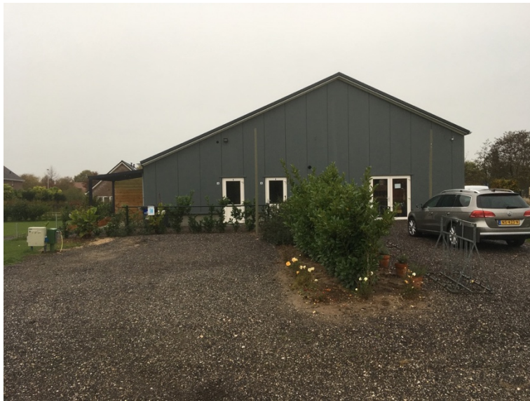
zuid zijde facilitair gebouw
