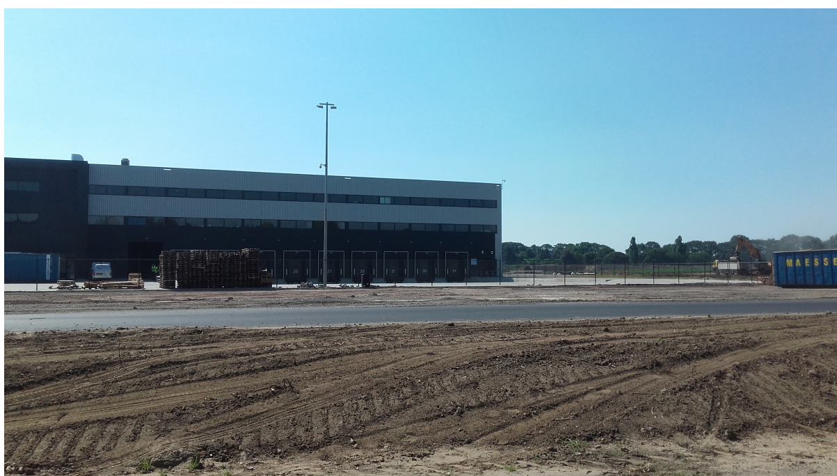
Afbeelding 4: bestaande bedrijfshallen Arvato in aanbouw
