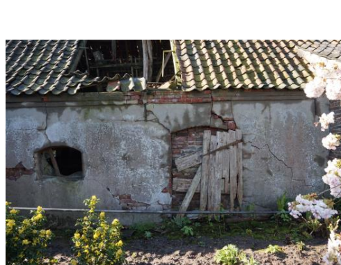
Stalvenster en loopdeur
