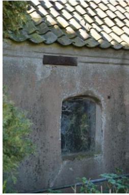
Relatief recent ingebracht anker
