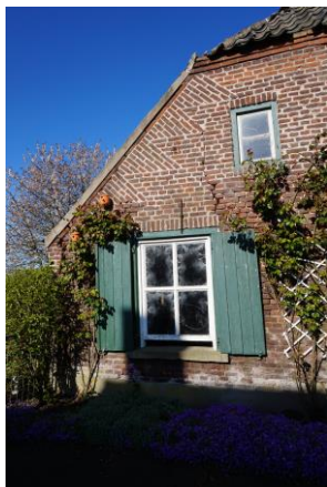
Begane grond, scheurvorming ter hoogte van kozijn. Aan de linkerszijde van de gevel is grote scheur aanwezig. De linkerzijmuur bolt op waardoor dit deel van de voorgevel afscheurd.
