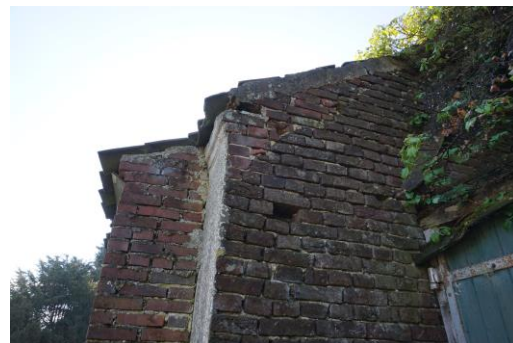
Verhoging van bestaande gevel
