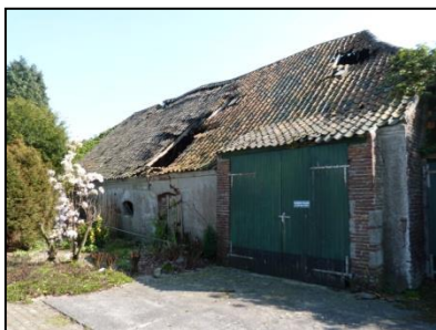
Figuur 3. Noordzijde van de te renoveren schuur.
