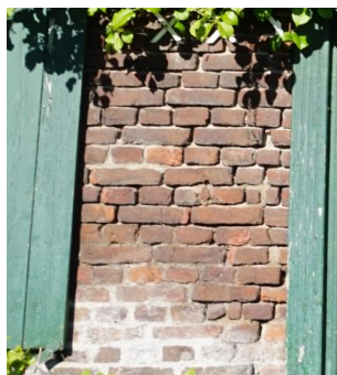
Voegwerk op begane grond
