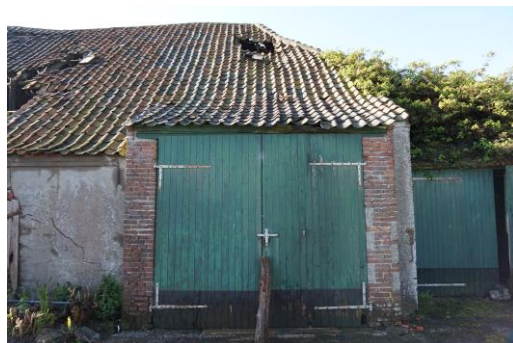
Latere verhoging, risalerent deel
