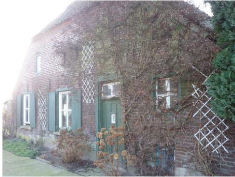
Kelder en opkamervensters aan rechterzijde deur Bron: Lenz Kerkhoff Architecten
