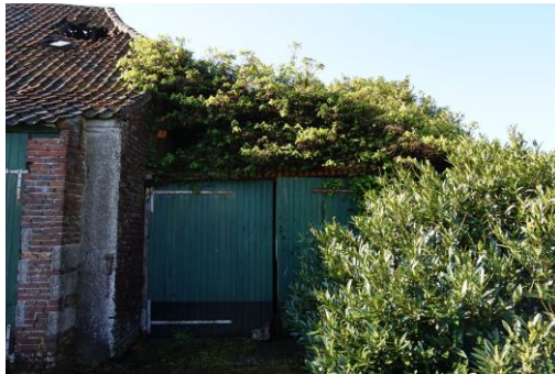
Deuren in aanbouw
