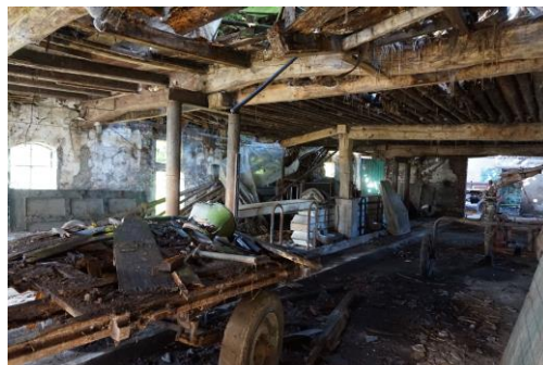
Zicht richting linkerzijgevel
