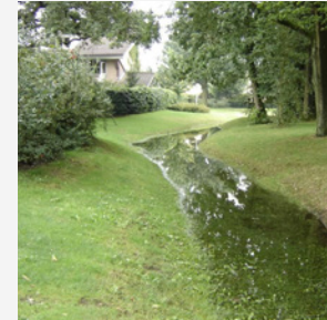
Wadi met flauw talud
