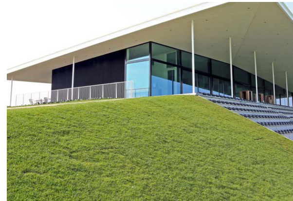
referentiebeeld: clubgebouw in/op groene 'dijk'
