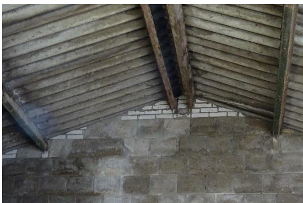
Afbeelding 12 t/m 17: Daken bijgebouwen afgesloten, of zonder dakbeschot. Bron: BNL advies Datum: 14-01-2022
