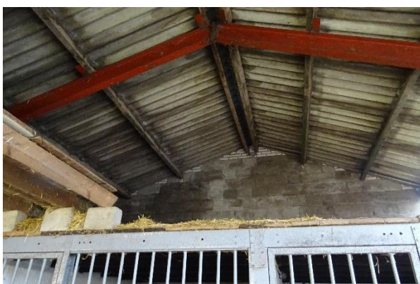
Afbeelding 12 t/m 17: Daken bijgebouwen afgesloten, of zonder dakbeschot. Bron: BNL advies Datum: 14-01-2022
