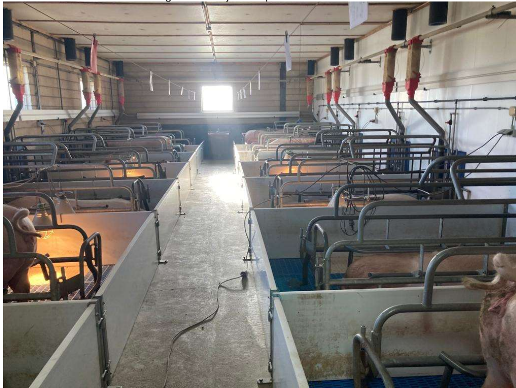
• Afbeelding 23: binnenzijde te slopen varkensstal
