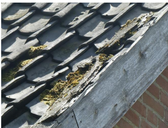
Afbeelding 15 t/m 20: Gaten, scheuren en andere openingen in het te verbouwen en slopen. Bron: BNL advies. Datum: 10-07-2023
