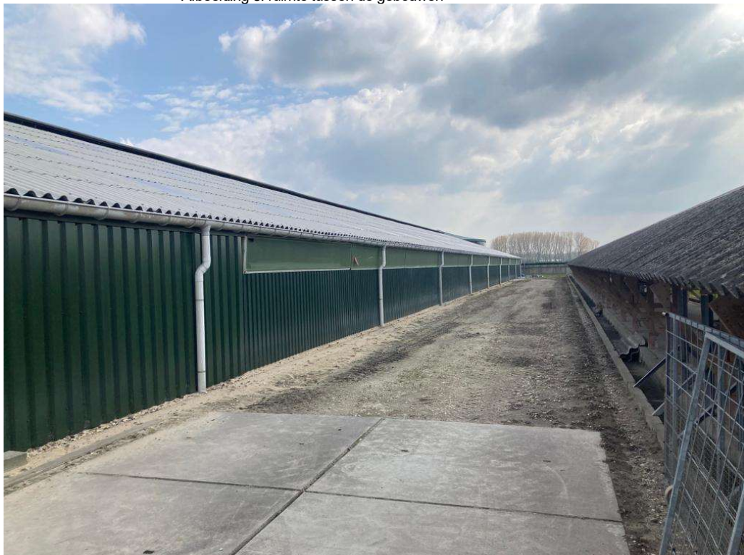
• Afbeelding 8: ruimte tussen de gebouwen
