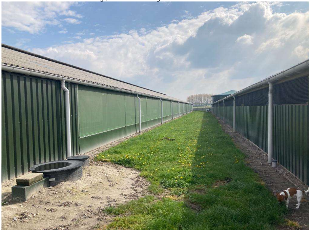
• Afbeelding 6: ruimte tussen de gebouwen
